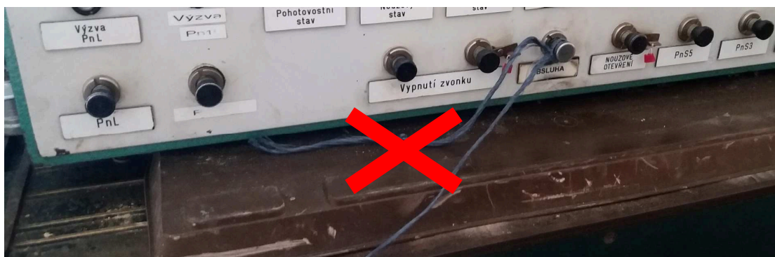
Obrázek 5: Příklad nedovoleného ovládání ovládacího prvku (provázek přivázaný k tlačítku)
