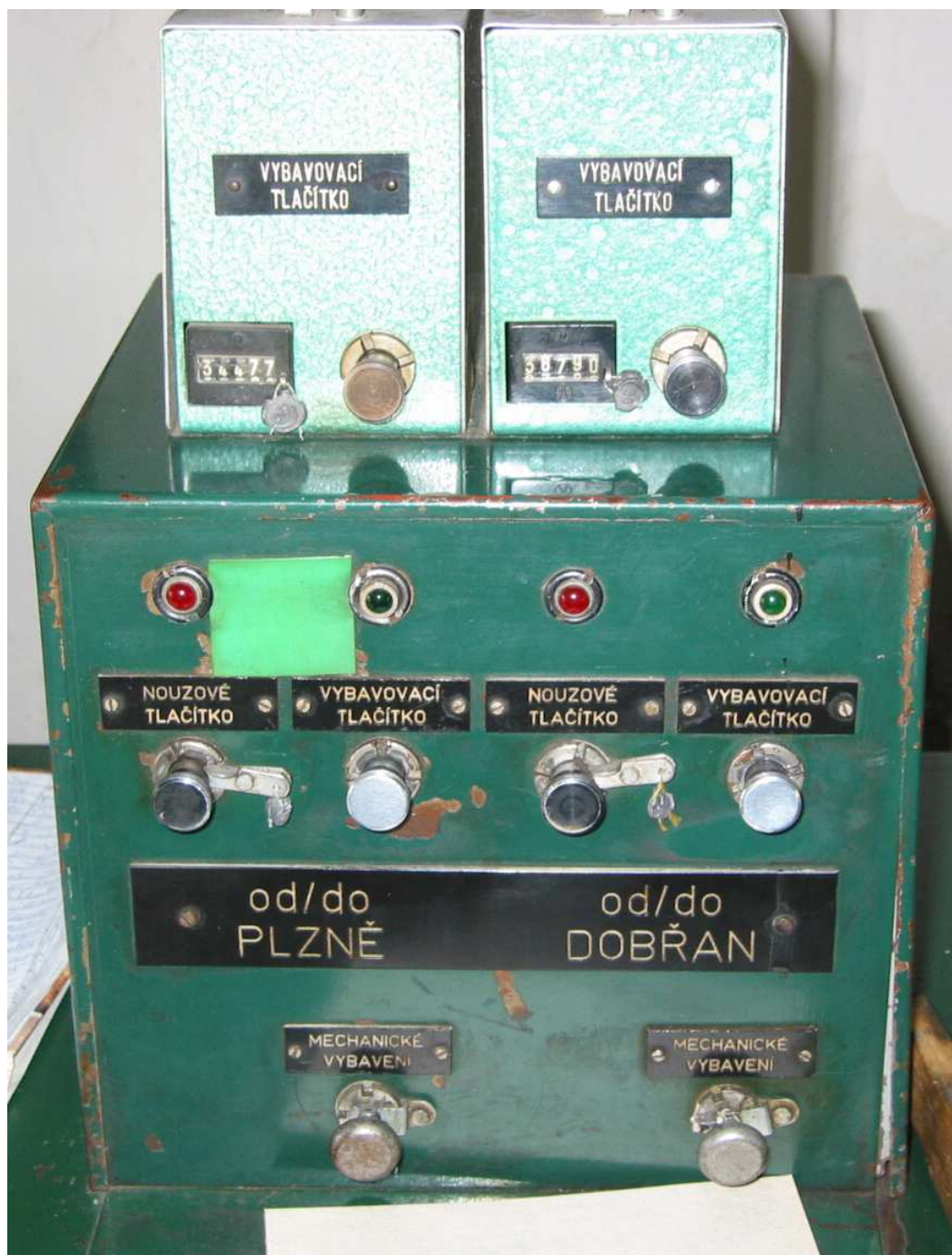
Samočinný závěr výměn – reléový vybavovač
