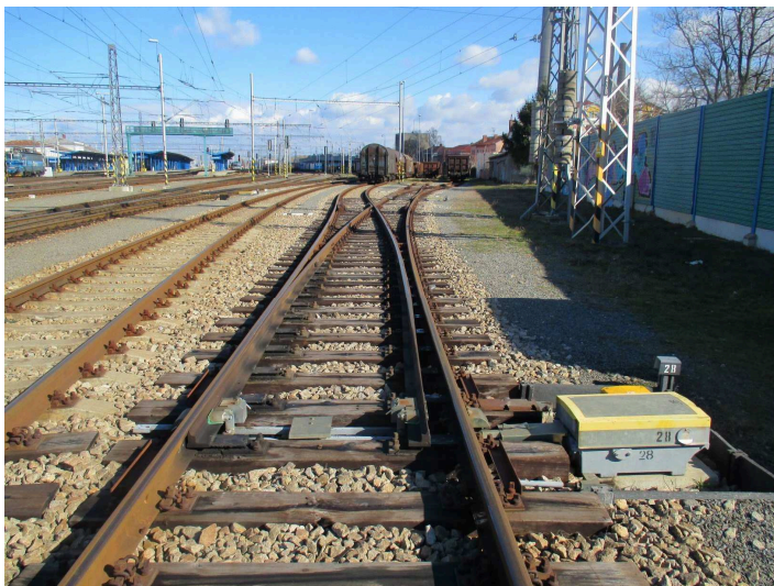
obrázek 51 – Jednoduchá výhybka oblouková oboustranná
