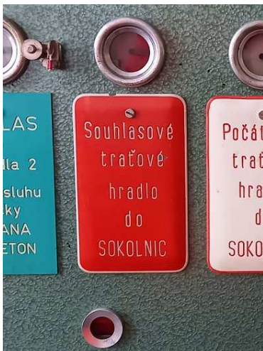
obrázek 327 – Traťové souhlasové hradlo (na řídicím přístroji)
