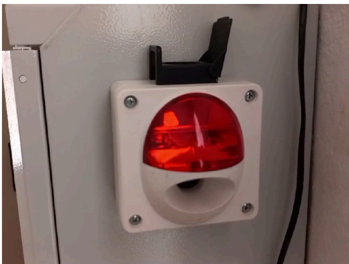
obrázek 238 – Siréna VNPN vnitřního provedení
