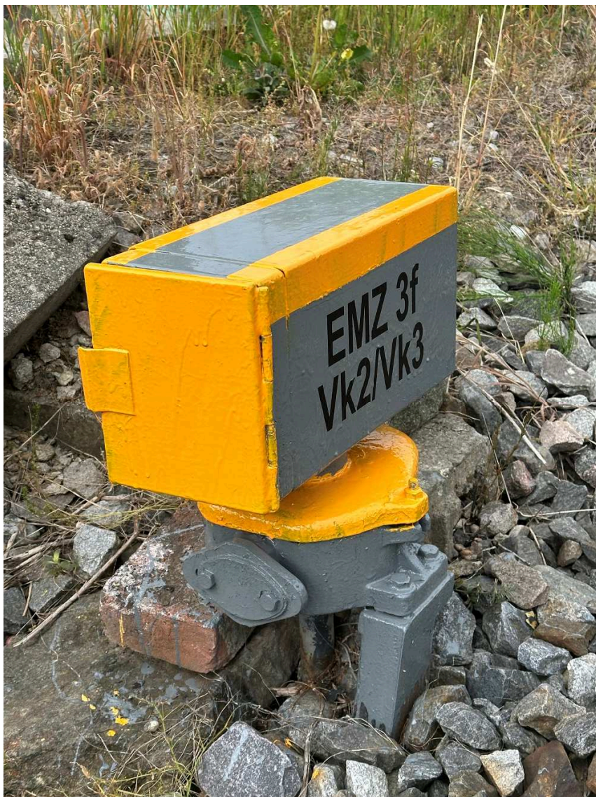
obrázek 156 – Elektromagnetický zámek třífázový (EMZ 3f)
