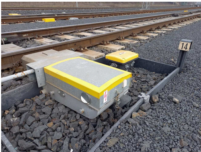
obrázek 175 – Elektrický přestavník
