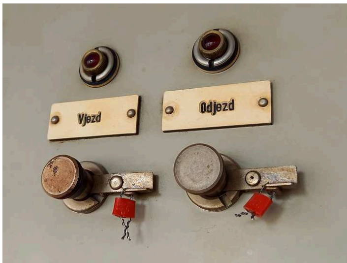
obrázek 32 – Příklad ovládacího prvku s plombou na drátu (ovládací prvek nefunkční – není aktivován, obsluhující zaměstnanec jej nesmí obsluhovat)
