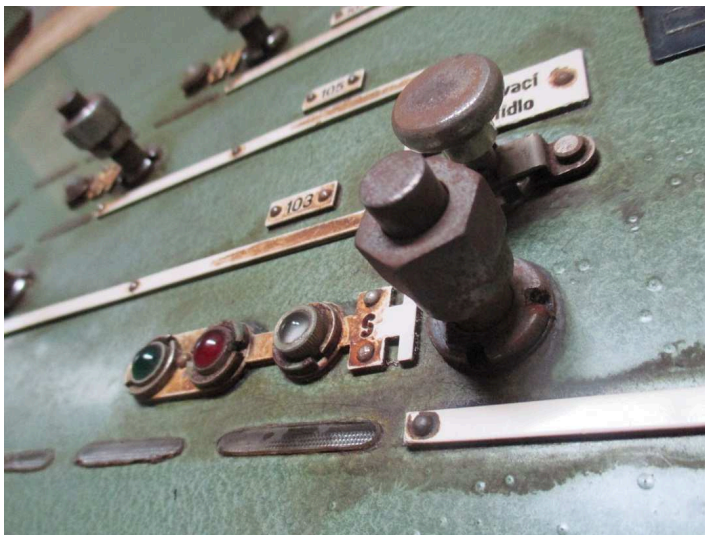
obrázek 13 – Sdružené návěstní tlačítko u makety hlavního návěstidla
