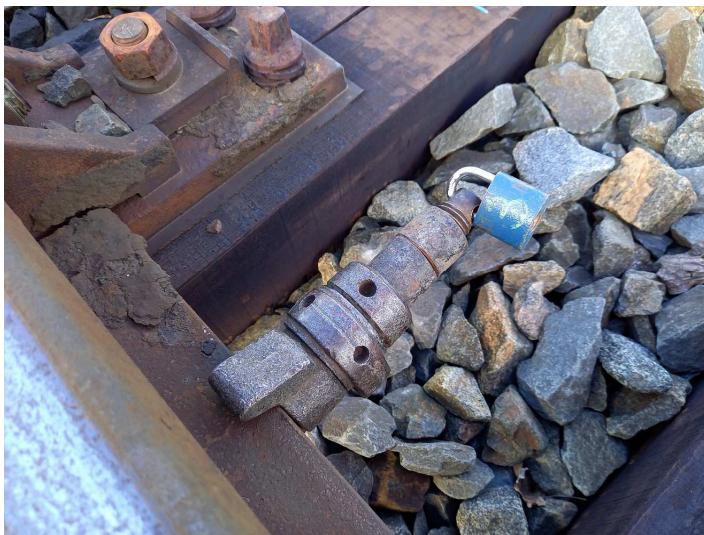
obrázek 140 – Nasazení jednoho nebo více mezikroužků na závit (za pojistnou matici) a uzamknutí přenosného výměnového zámku visacím zámekm
