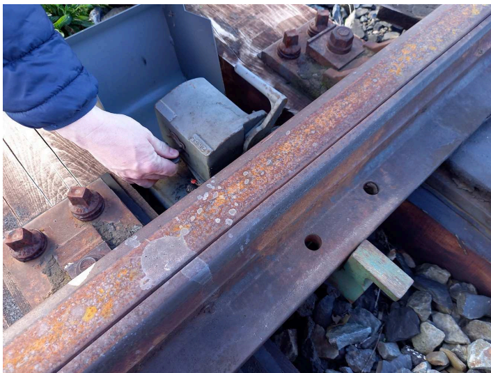
obrázek 131 – Uzamknutí výměnového zámku klíčem
