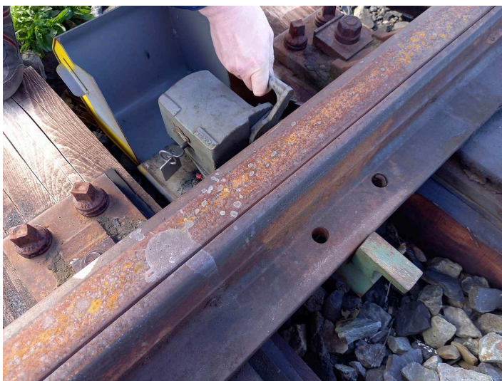
obrázek 130 – Zvednutí závěrného háku výměnového zámku do svislé polohy
