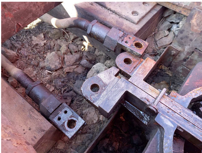
obrázek 192 – Vychýlení obou závorníkových spojnic (po sejmutí všech plomb na drátu, šroubů pojistných plechů, pojistných plechů a vyjmutí spojovacích čepů)
