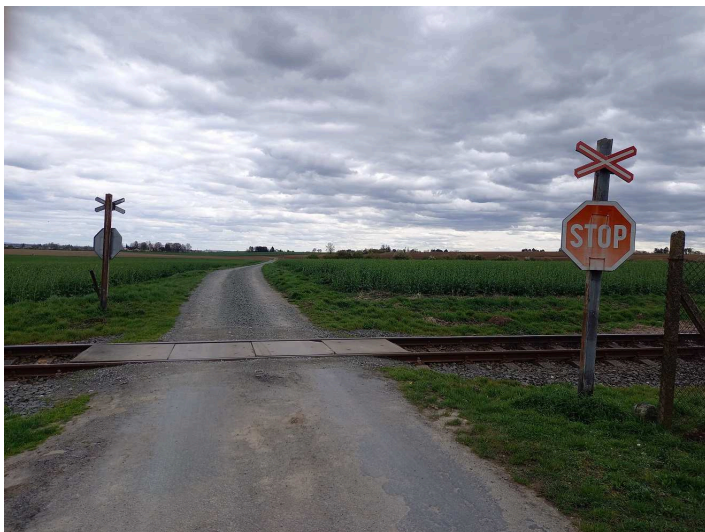
obrázek 395 – Přezjezd jednokolejný zabezpečený pouze výstražnými kříži
