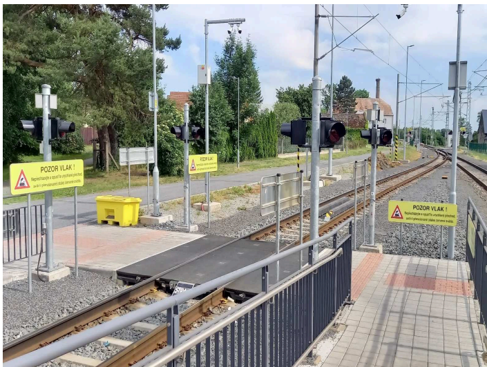
obrázek 414 – Přechod s výstražným zařízením pro přechod kolejí
