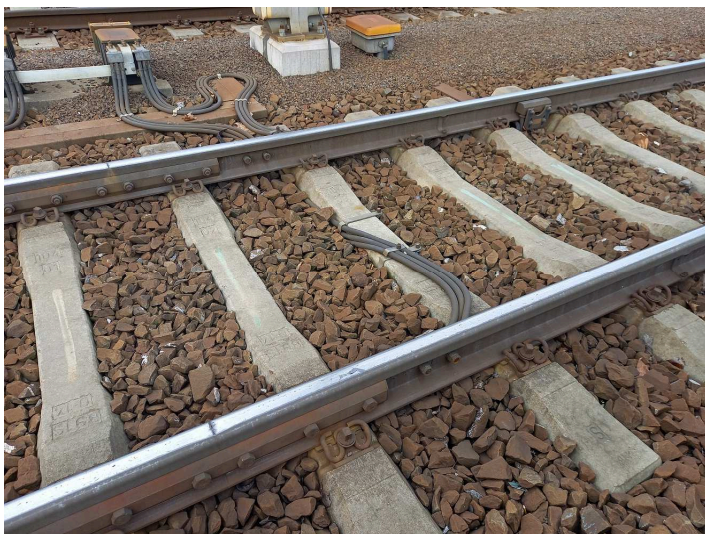
obrázek 229 – Kombinace kolejového obvodu a počítače náprav
