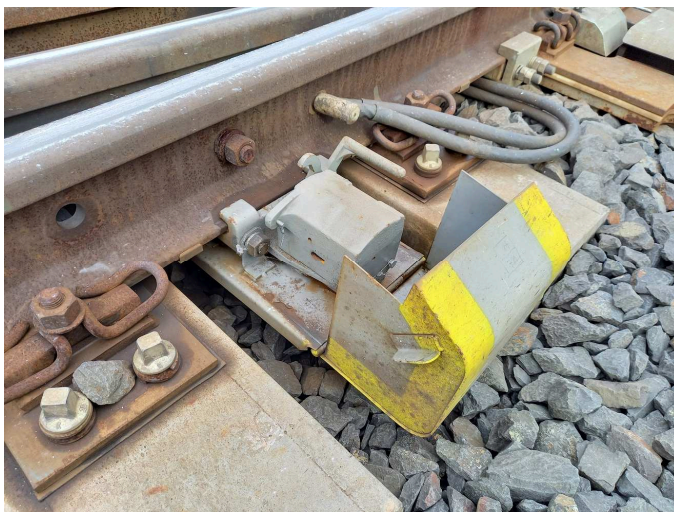
obrázek 99 – Odklopená ochranná skříňka mechanického zámku
