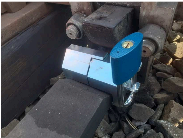
obrázek 147 – Uzamknutí PZČZ visacím zámkem (uzamykatelným otvorem směrem nahoru, např. z nedostatku místa)
