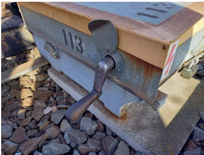
obrázek 177 – Klika pro přestavování výhybky (výkolejky) nouzově ručním způsobem, vložená v otvoru elektrického přestavníku
