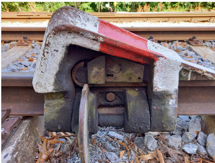
obrázek 118 – Výkolejkový zámek jednoduchý (starší typ výkolejky)
