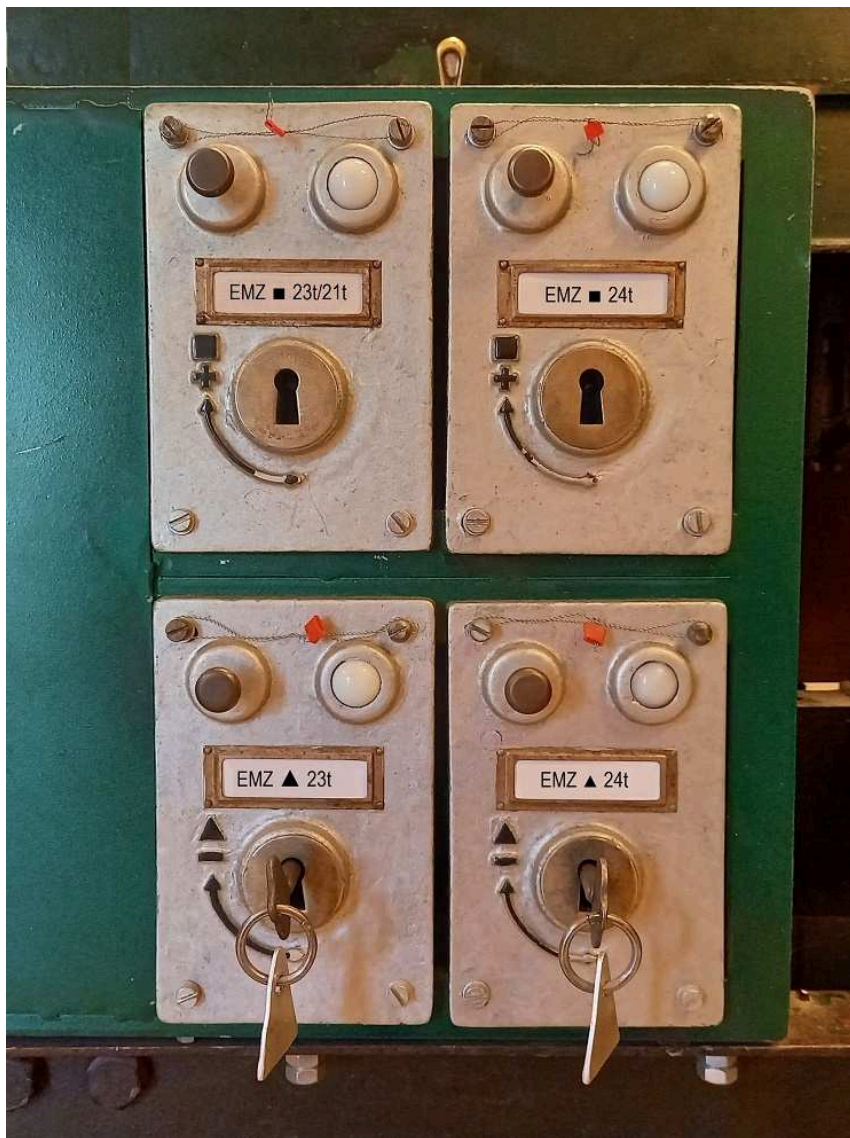
obrázek 154 – Elektromagnetické zámky vnitřního provedení (bez tlačítka pro nouzové uvolnění klíče)
