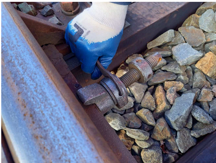
obrázek 138 – Dotažení oválné matice pomocí speciálního klíče
