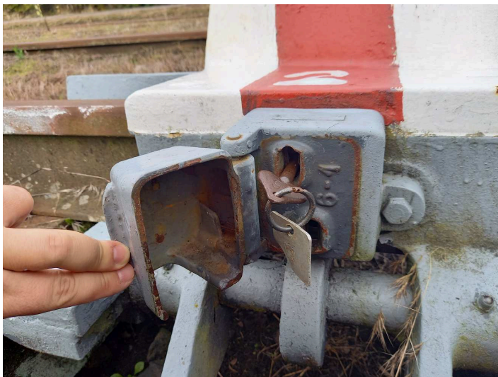
obrázek 114 – Výkolejkový zámek kontrolní (novější typ výkolejky)
