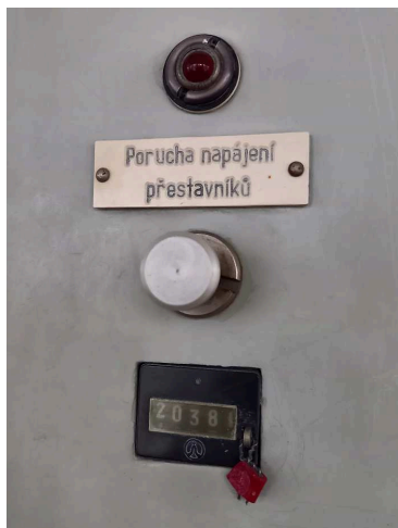
obrázek 3 – Tlačítko s počítadlem
