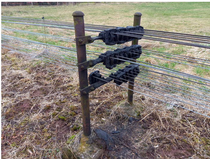
obrázek 217 – Drátovody v místě vodících kladek
