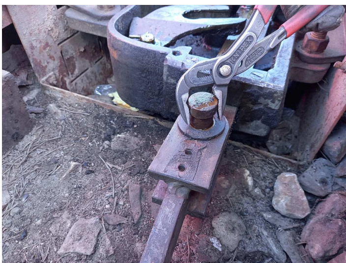
obrázek 169 – Vyjmutí spojovacího čepu
