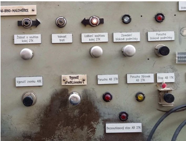
obrázek 390 – Ovládací a indikační prvky automatického bloku ABE-1
