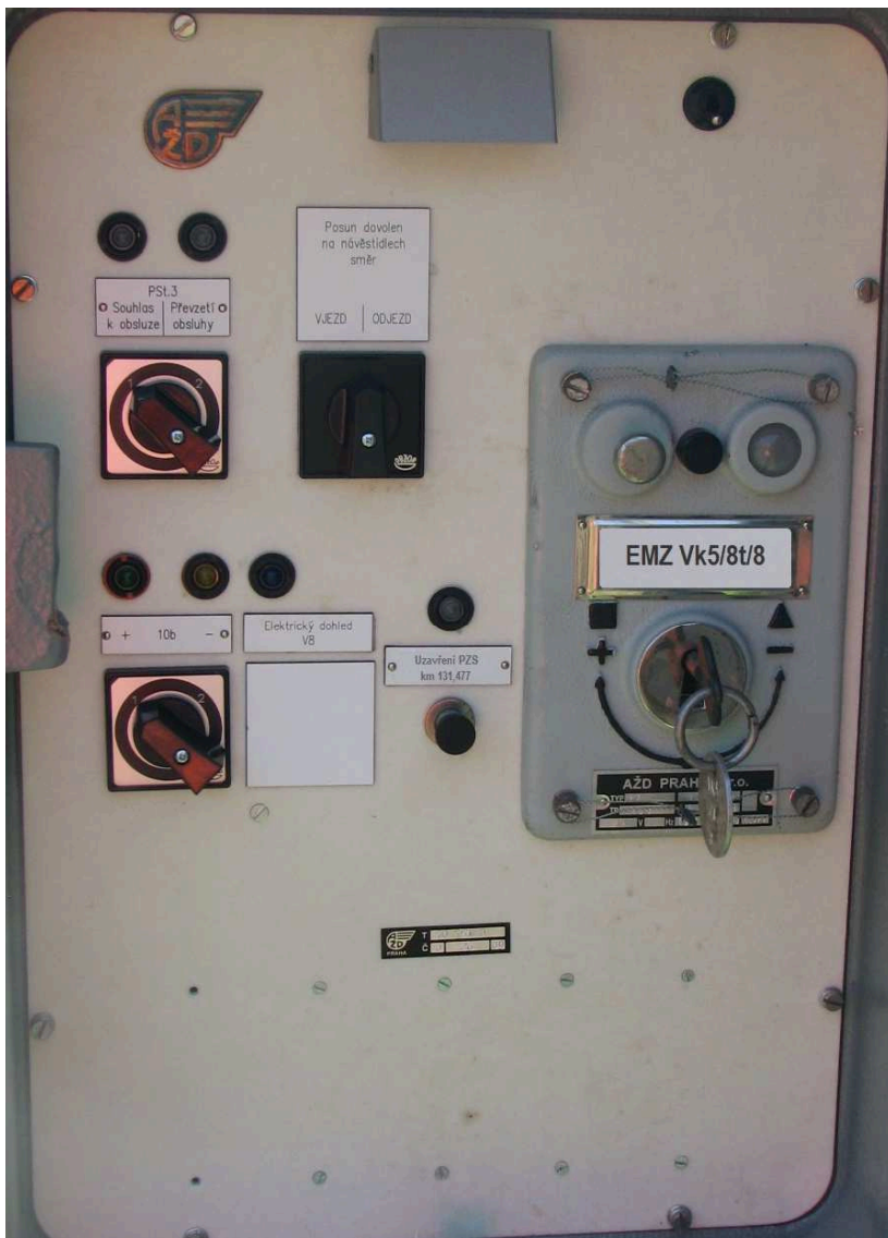
obrázek 223 – Detail pomocného stavědla vnějšího provedení s jednotlivě přestavovanými výhybkami, s elektromagnetickým zámekem a ovládacími a indikačními prvky PZS
