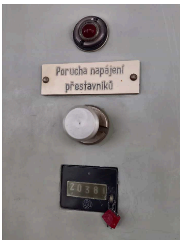
obrázek 7 – Odjištěná uzávěra proti náhodné obsluze (starší typ)
