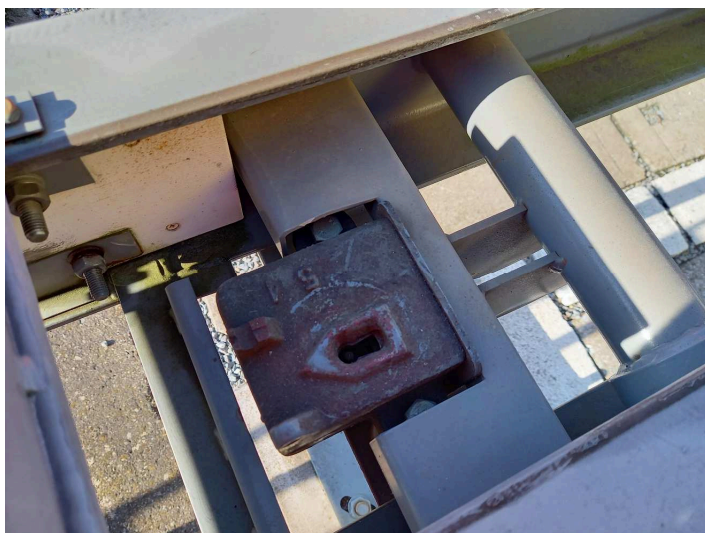
obrázek 406 – Detail PZM 2U (zámkový mechanismus jednoduchého zámku po odklopení krytu)
