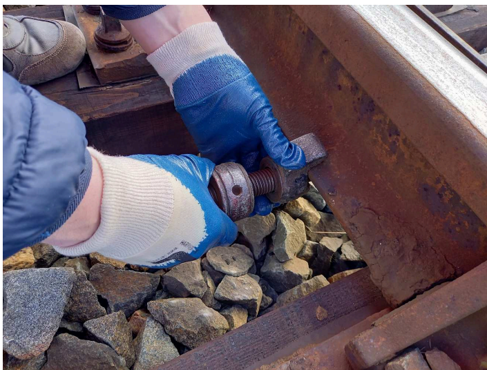
obrázek 136 – Nasazení svěrky na opačný konec háku, její zaklesnutí za patu kolejnice
