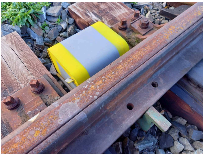
obrázek 133 – Naklopení ochranné skříňky výměnového zámku (po jeho uzamknutí a vyjmutí klíče)
