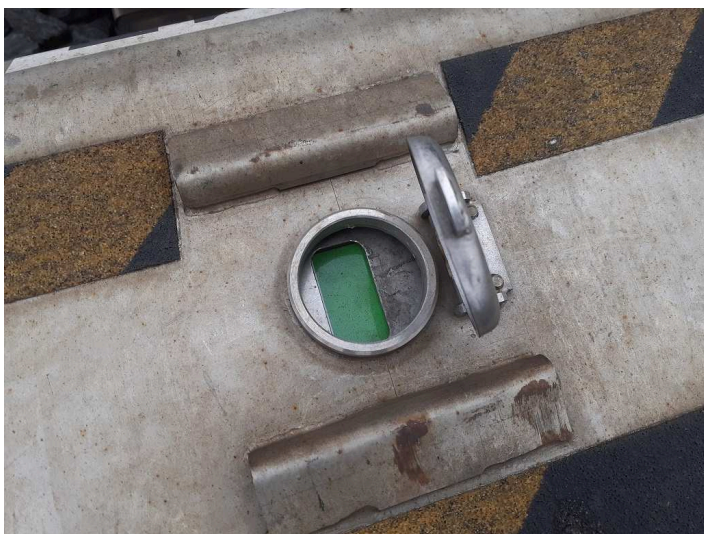
obrázek 47 – Indikace uzavření vnitřního závěru u výhybky s hydraulickým přestavníkem a vnitřním závěrem
