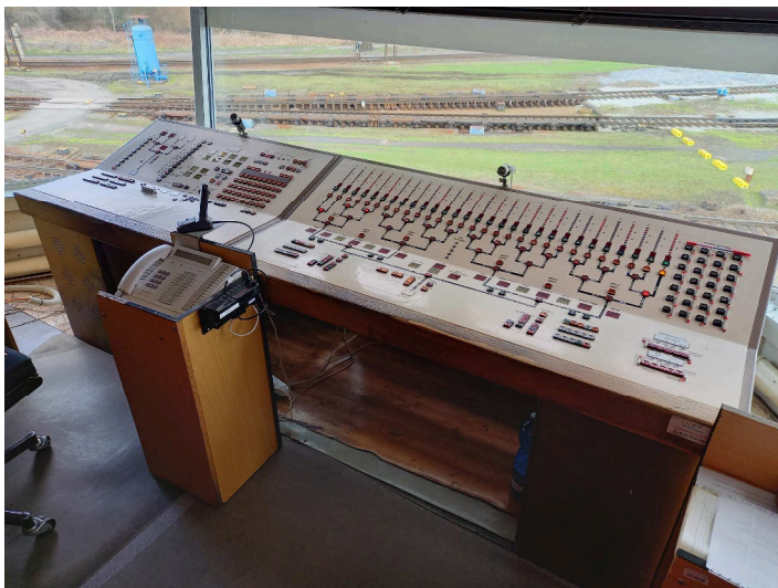
obrázek 434 – Ovládací stůl spádovištního systému KOMPAS 5
