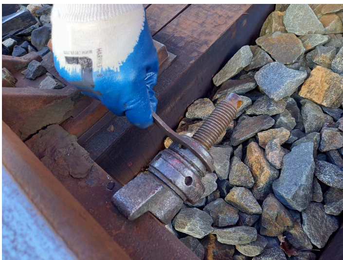
obrázek 139 – Zajištění oválné matice dotažením druhé pojistné matice pomocí speciálního klíče
