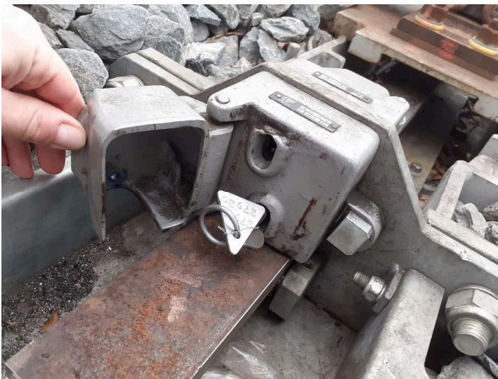
obrázek 112 – Závěrový zámek (konstrukčně v provedení jako kontrolní výkolejkový zámek)
