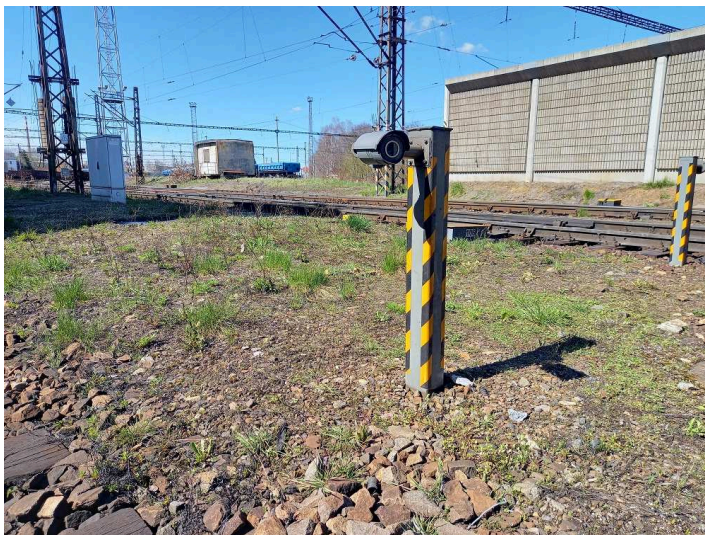
obrázek 439 – Kamera pro snímání oblasti brzd
