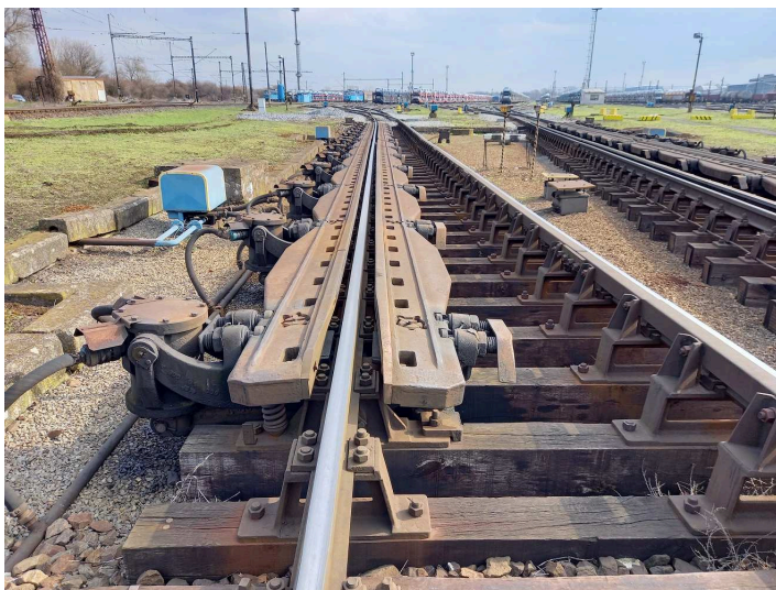
obrázek 424 – Pneumatická jednokolejnicová brzda
