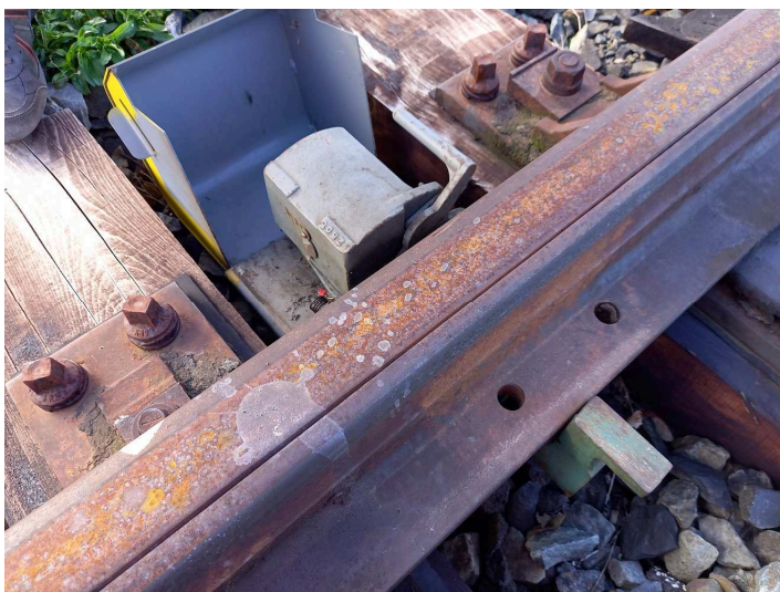
obrázek 132 – Vyjmutí klíče z uzamknutého výměnového zámku
