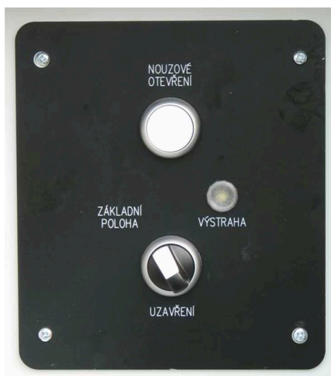
obrázek 417 – Ovládací a indikační prvky skříňky místní obsluhy
