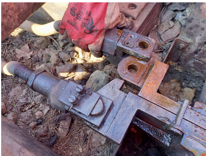
obrázek 191 – Vychýlení závorníkové spojnice
