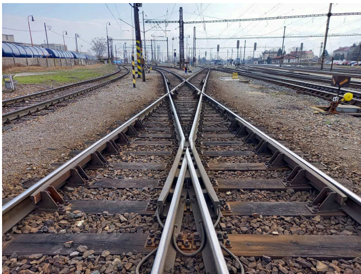
obrázek 63 – Kolejová křižovatka
