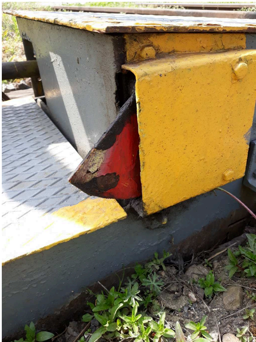
obrázek 160 – Detail vysunuté červené výseče u mechanického trojpolohového přestavníku s pružinou při předání na ruční přestavování
