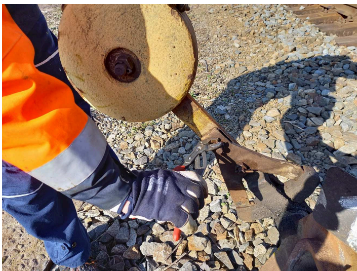
obrázek 171 – Vytažení závlačky podpěrné vidlice
