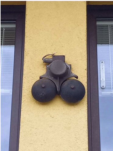
obrázek 381 – Venkovní akustické zařízení pro předávání zvonkových znamení
