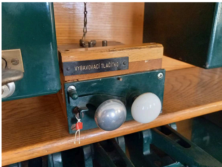
obrázek 304 – Vybavovací tlačítko
