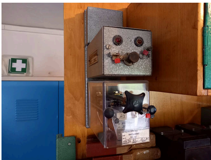
obrázek 307 – Vyhodnocovací zařízení pro kontrolu obsazení a uvolnění izolované kolejnice
