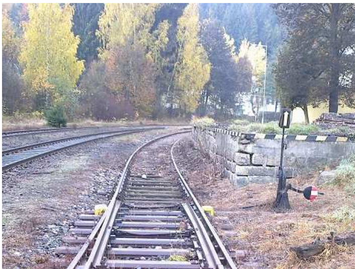
obrázek 58 – Výhybka bez závěru jazyků (starší provedení výměníku, kde v základní poloze výhybky směřuje černá polovina závaží k výměně)
