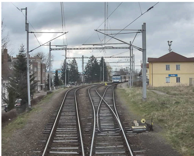
obrázek 52 – Jednoduchá výhybka oboustranná
