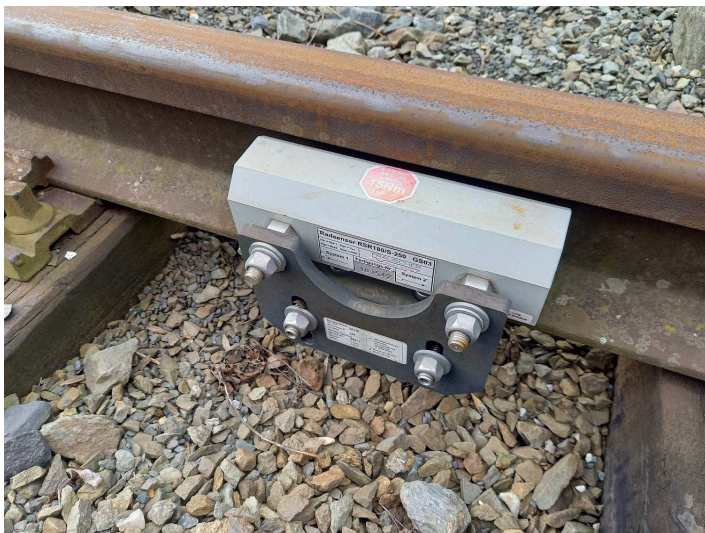
obrázek 228 – Snímač 1 počítače náprav (PCN)
