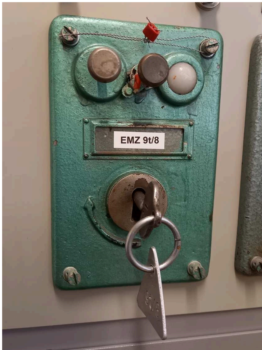
obrázek 153 – Elektromagnetický zámek vnitřního provedení (včetně tlačítka s plombou na šňůrce pro nouzové uvolnění klíče)
