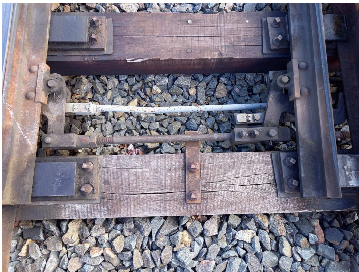
obrázek 76 – Spojovací tyč
