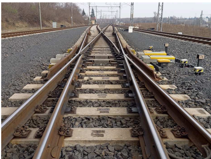
obrázek 64 – Kolejová křižovatka s PHS
