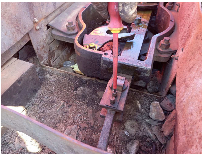
obrázek 168 – Vyšroubování šroubů pojistných plechů a sejmutí pojistných plechů
