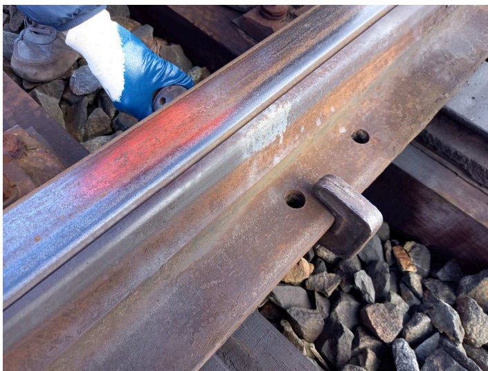
obrázek 135 – Vsunutí háku pod patu kolejnice a jeho zaklesnutí za přilehlý jazyk výhybky
