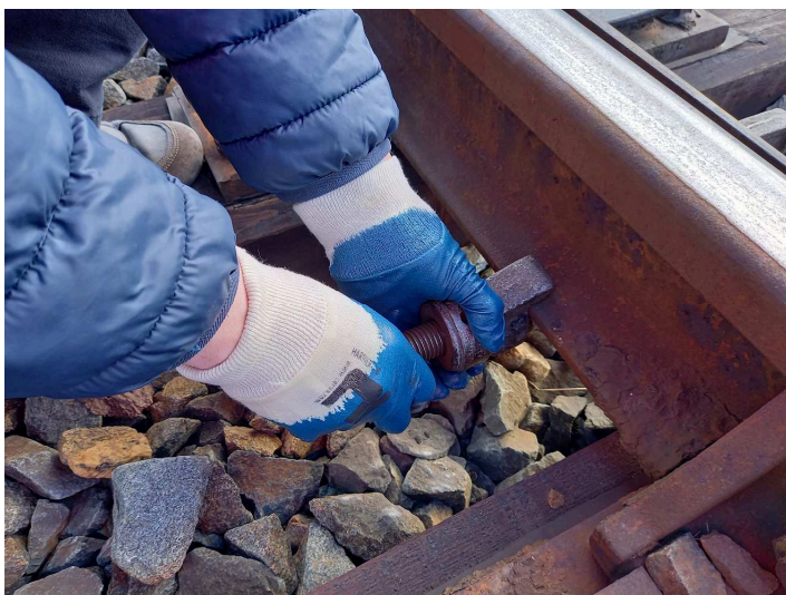
obrázek 137 – Zajištění oválnou maticí
