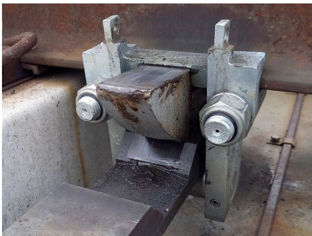
obrázek 45 – Nominální podepření závěrového háku u výhybky s čelistovým závěrem jazyku
