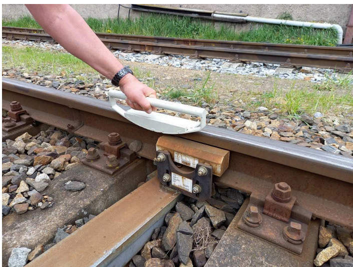
obrázek 455 – Příklad použití zatlumovacího plechu zaměstnancem OUZZ (nad snímačem PCN)
