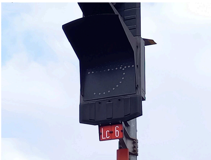
obrázek 210 – Detail indikátoru světelného hlavního návěstidla
