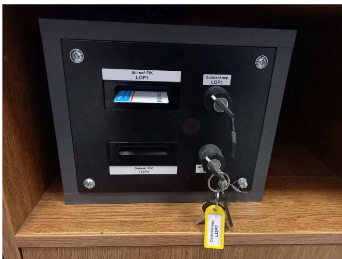
obrázek 375 – Kontrolní vstup pro personální identifikační kartu a tlačítka pro reset zadávacích počítačů (pro hlavní i záložní ovládací pracoviště)
