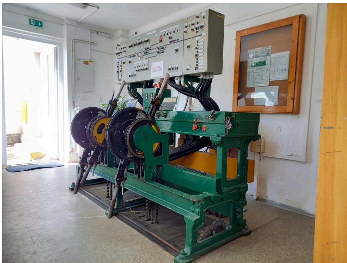
obrázek 239 – Ústřední přístroj (doplňný indikační deskou)
