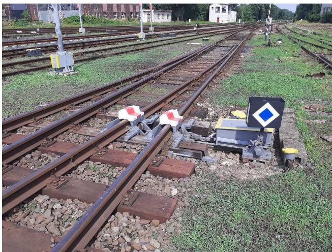
obrázek 89 – Příklad výkolejky s dvěma svodnými klíny
