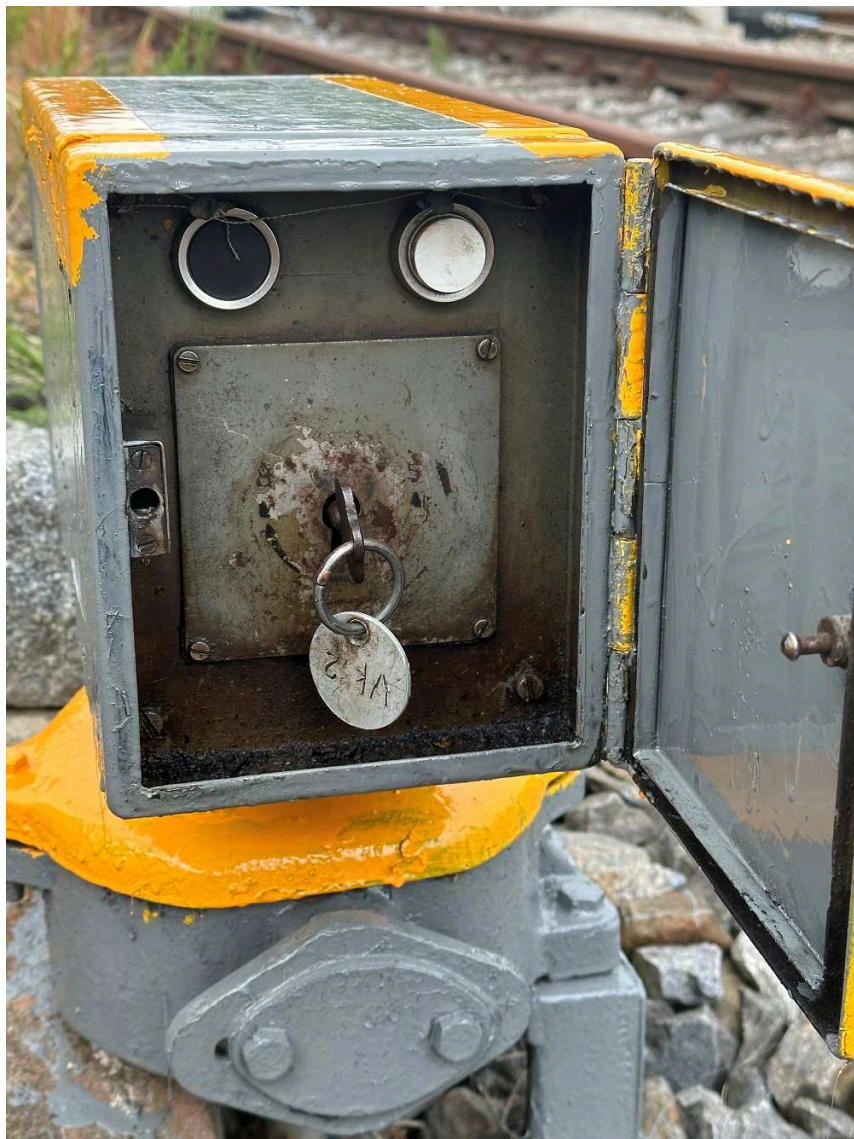
obrázek 157 – Detail elektromagnetického zámku třífázového (EMZ 3f)
