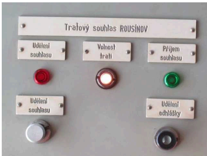
obrázek 384 – Ovládací a indikační prvky reléového poloautomatického bloku
