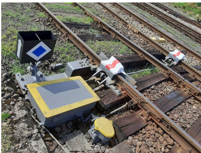
obrázek 90 – Příklad výkolejky s dvěma svodnými klíny
