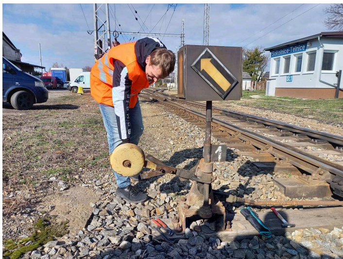
obrázek 174 – Koncová poloha páky se závažím po provedené úpravě podpěrné vidlice
