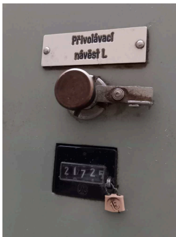
obrázek 4 – Tlačítko s uzávěrou proti náhodné obsluze, starší typ, neplombované, s počítadlem
