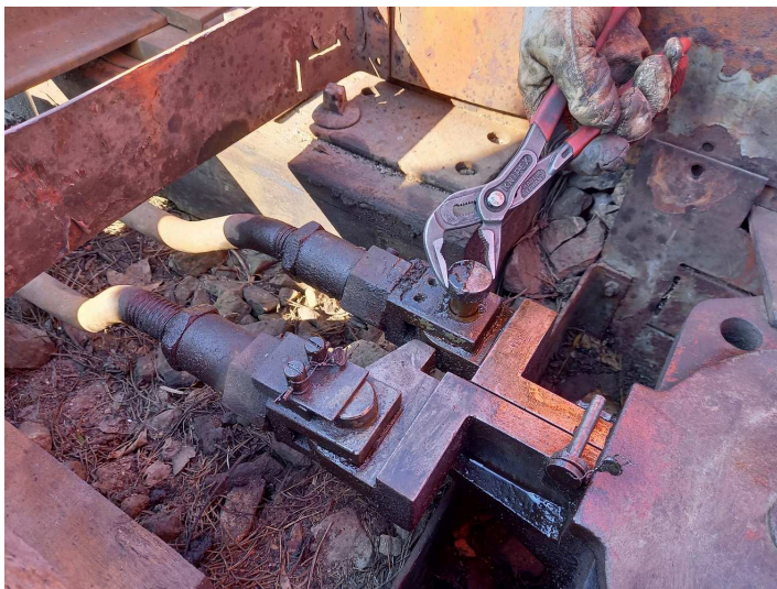
obrázek 190 – Vyjmutí spojovacího čepu
