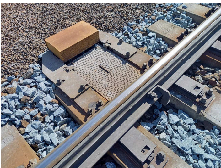
obrázek 55 – Snímač polohy jazyka
