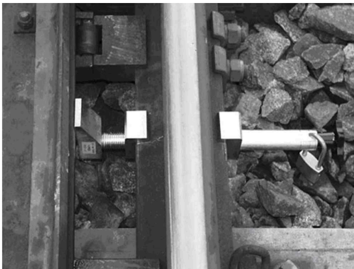
obrázek 122 – Přenosný odtlačný zámek
