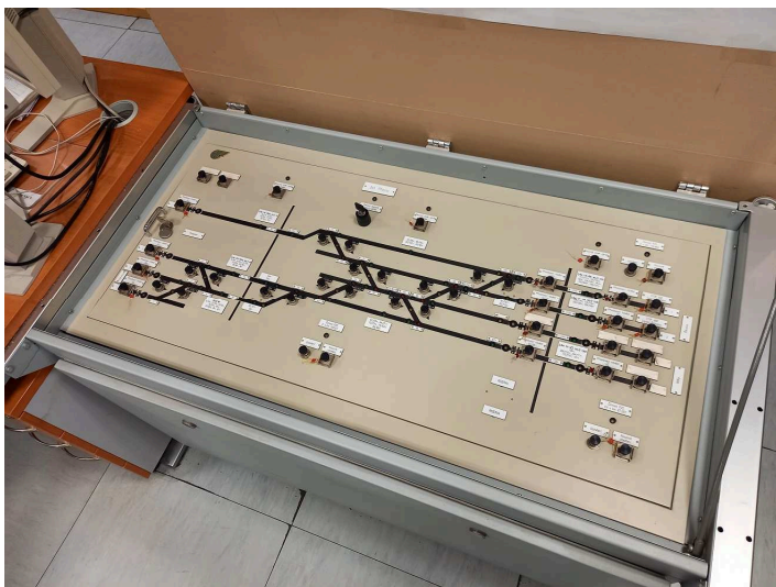
obrázek 368 – Deska nouzových obsluh pro větší stanici
