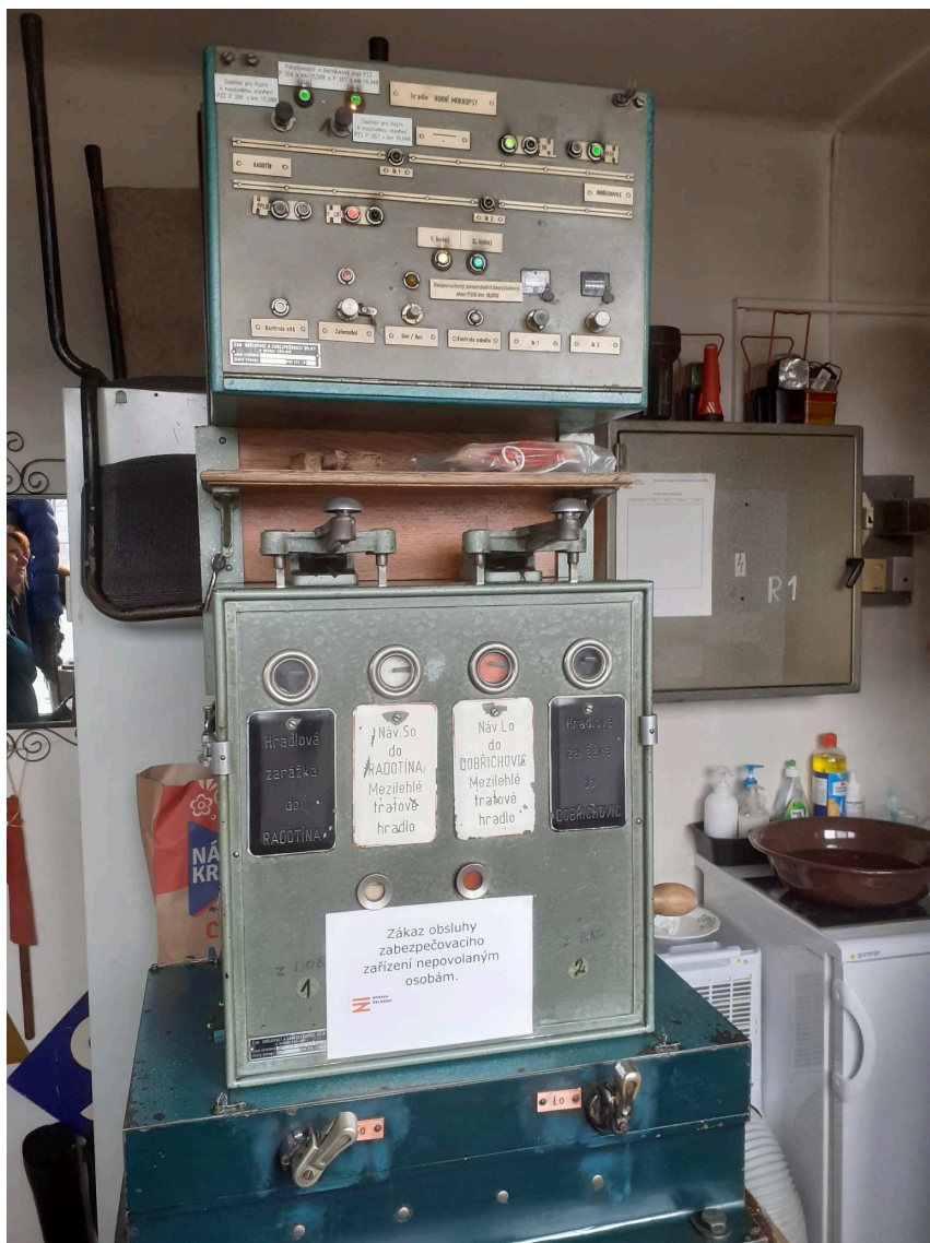
obrázek 382 – Hradlový přístroj na hradle (hradlový poloautomatický blok)
