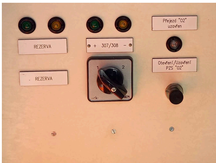
obrázek 418 – Ovládací a indikační prvky PZS umístěné v pomocném stavědle
