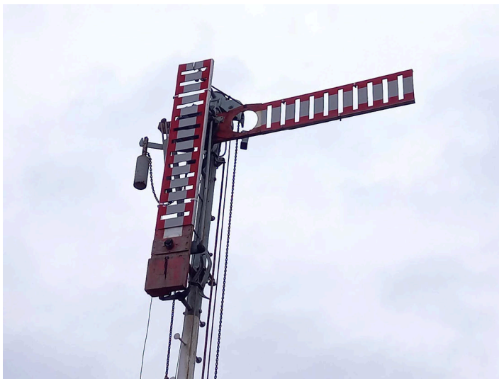
obrázek 199 – Detail horní části mechanického hlavního návěstidla dvouramenného
