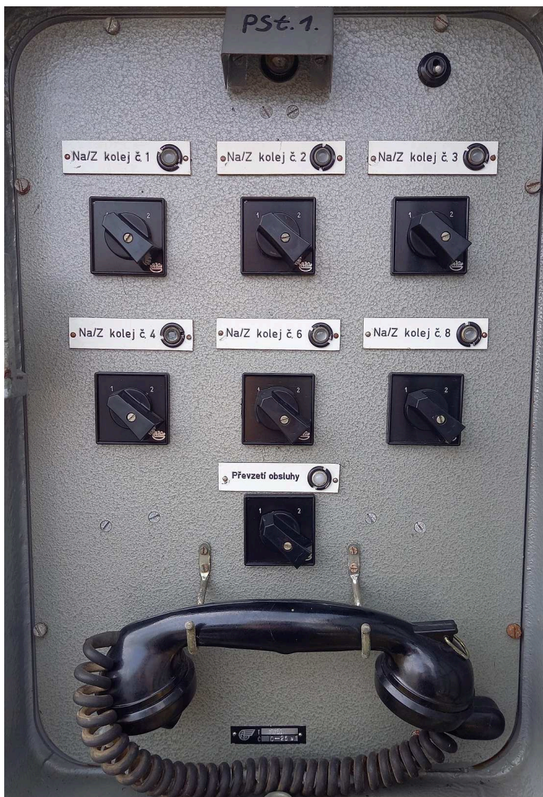
obrázek 221 – Detail pomocného stavědla vnějšího provedení se skupinově přestavovanými výhybkami
