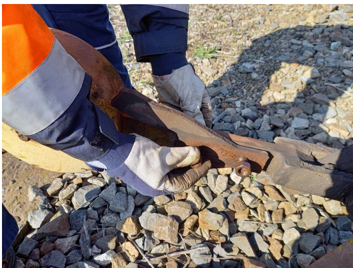
obrázek 173 – Otočení podpěrné vidlice o 180°
