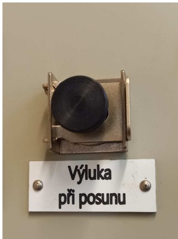
obrázek 2 – Tlačítko s uzávěrou proti náhodné obsluze, novější typ, neplombované
