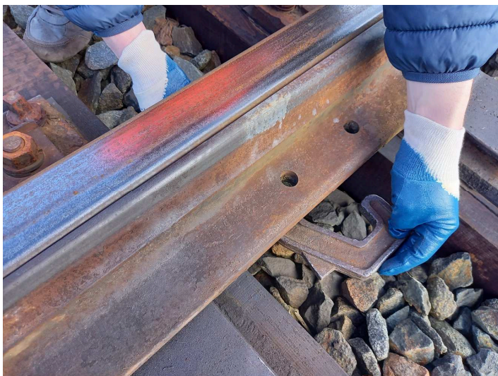
obrázek 134 – Umístění přenosného výměnového zámku do příslušného mezipražcového pole
