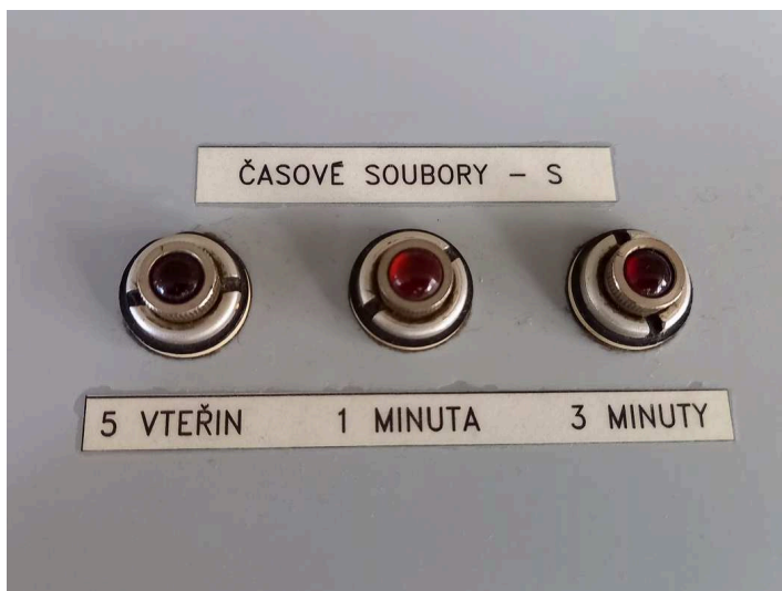
obrázek 342 – Detail kolejového reliéfu s indikačními a ovládacími prvky (časové soubory)
