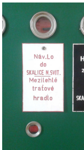
obrázek 326 – Meziúhlé traťové hradlo (na hradlovém přístroji na hradle)
