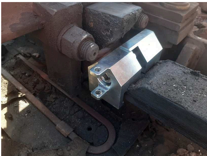
obrázek 143 – Nasazení PZČZ do vybraní závorovacího pravítka
