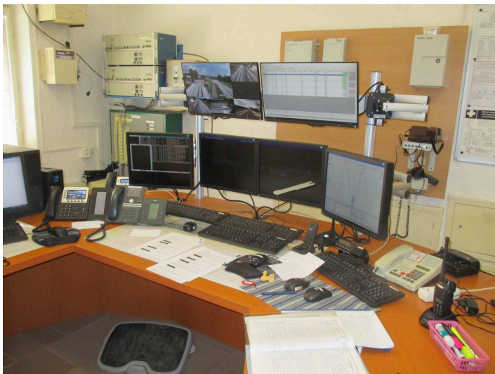
obrázek 364 – Jednotné obslužné pracoviště SZZ ESA (případně SZZ-ETB)
