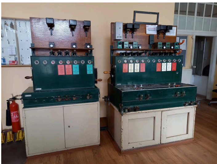
obrázek 244 – Přídavný přístroj (vlevo) s mechanickými závislostmi na řídicím přístroji (prostřednictvím zástrčkových zámků)
