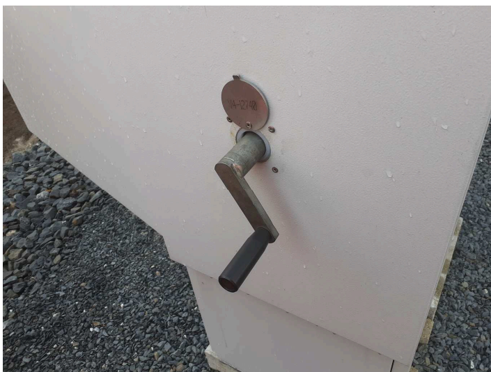
obrázek 181 – Klika pro přestavování části výhybky s hydraulickými přestavníky (výměnová část, PHS) nouzově ručním způsobem, vložená v otvoru skříně hydraulického systému
