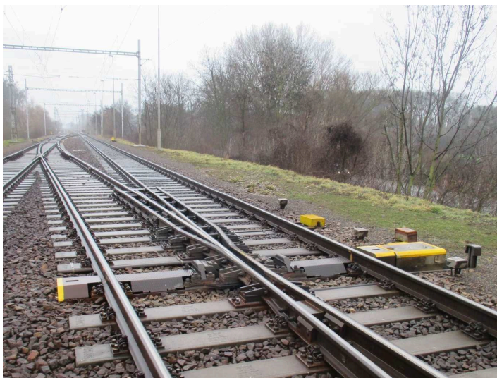
obrázek 72 – PHS u jednoduché výhybky
