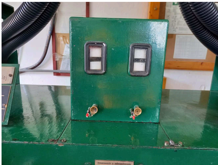
obrázek 332 – Samočinný závěr výměn (s okénkem rozděleným na dvě poloviny)
