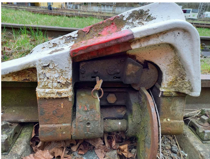
obrázek 119 – Výkolejkový zámek kontrolní (starší typ výkolejky)
