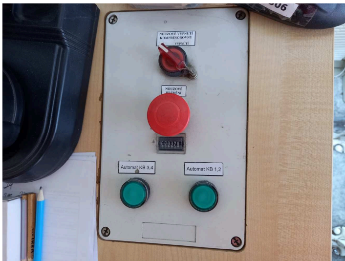
obrázek 430 – Ovládací prvek pro nouzové vypnutí kolejových brzd
