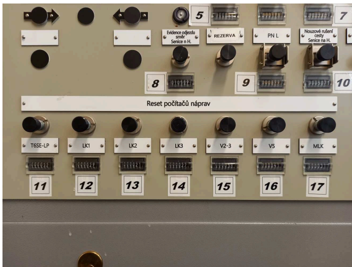
obrázek 357 – Detail indikační desky SZZ TEST – soubor s tlačítky pro reset počítačů náprav (PCN)
