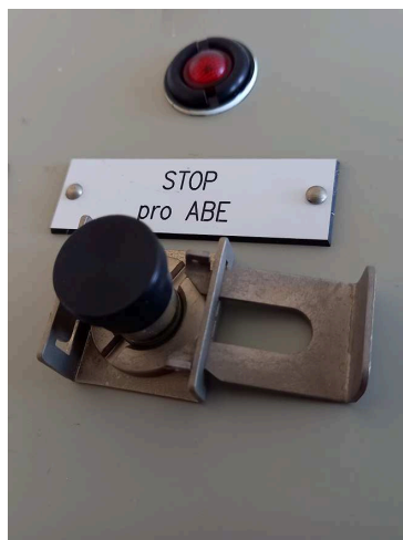
obrázek 8 – Odjištěná uzávěra proti náhodné obsluze (novější typ)
