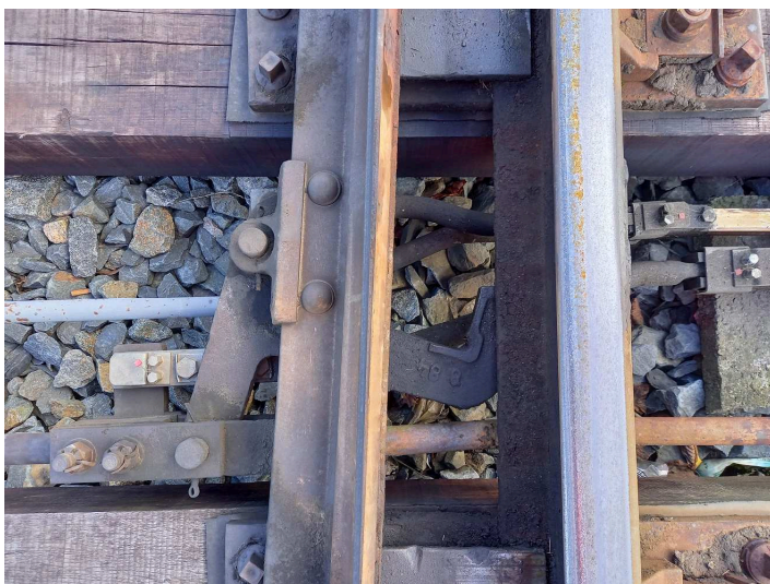
obrázek 77 – Přestavná spojnice
