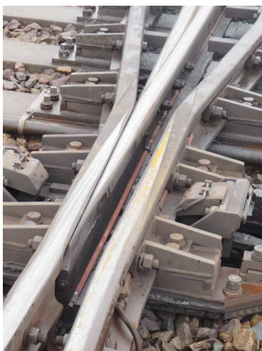
obrázek 68 – PHS přiléhající ke křídlové kolejnici (jednoduchá výhybka)
