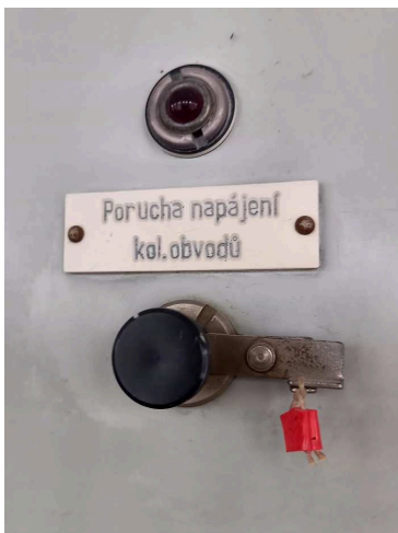
obrázek 5 – Tlačítko s uzávěrou proti náhodné obsluze, starší typ, plombované (plomba na šňůrce)
