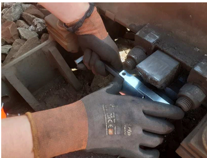
obrázek 144 – Sevření svěracích čelistí PZČZ utažením INBUS šroubu
