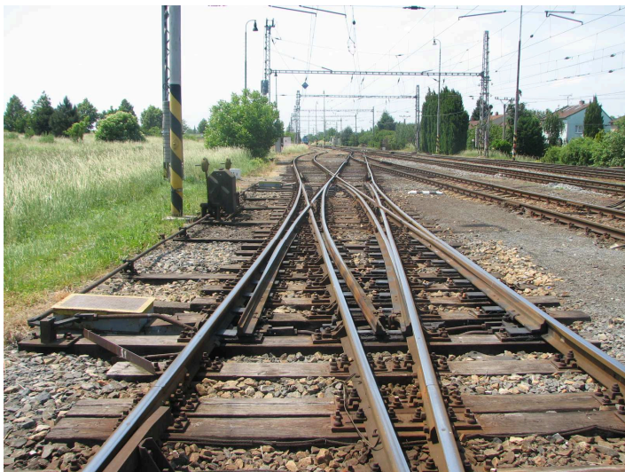
obrázek 59 – Křižovatková výhybka celá
