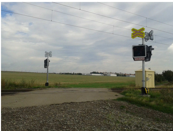
obrázek 408 – Přejezd s PZS bez závor (příklad více kolejného přejezdu)
