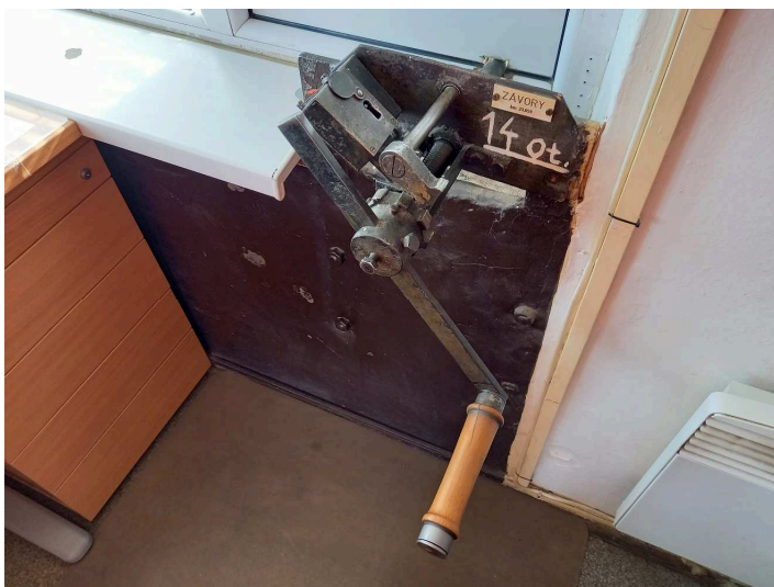
obrázek 400 – Ovládací prvek PZM 2
