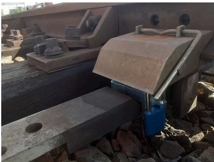
obrázek 148 – Nasazený kryt svěrací čelisti po zajištění výhybky (uzamknutí výhyby PZČZ)
