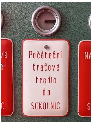
obrázek 323 – Počáteční traťové hradlo (na řídicím přístroji)
