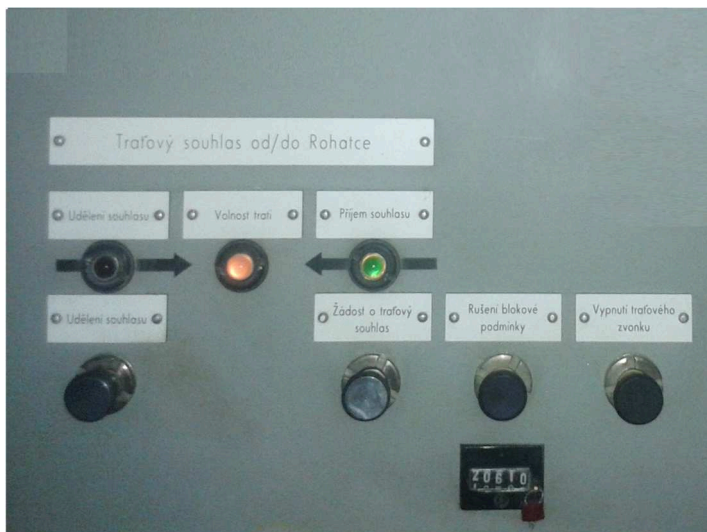
obrázek 387 – Ovládací a indikační prvky automatického hradla AH-88A
