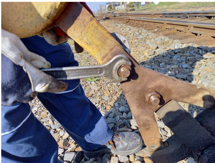
obrázek 172 – Povolení šroubů podpěrné vidlice
