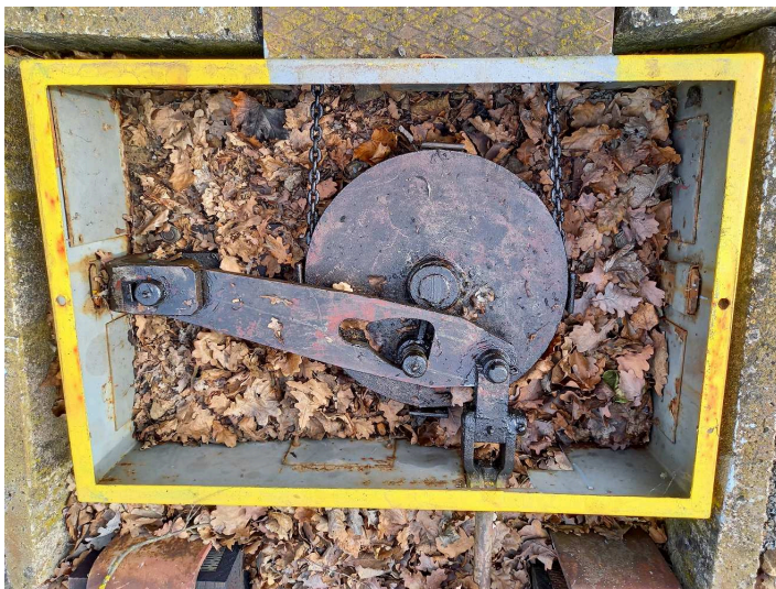
obrázek 161 – Mechanický přestavník pro výkolejku (nerozřezný)
