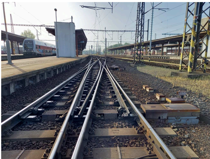
obrázek 61 – Křižovatková výhybka s PHS celá
