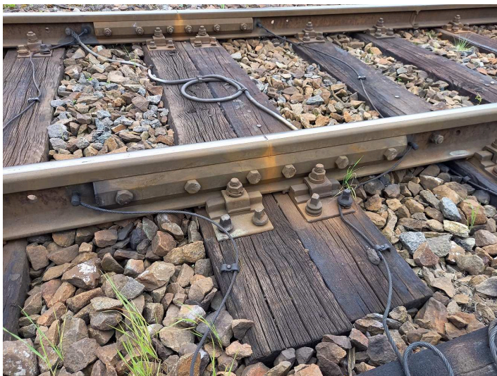
obrázek 226 – Izolovaný styk
