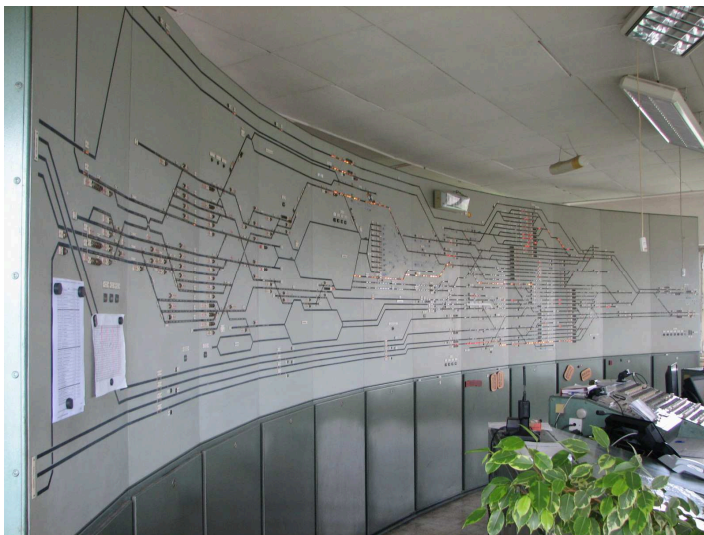
obrázek 344 – Indikační deska RZZ cestového systému se skupinově přestavovanými výhybkami (výkolejkami) s číslicovou volbou
