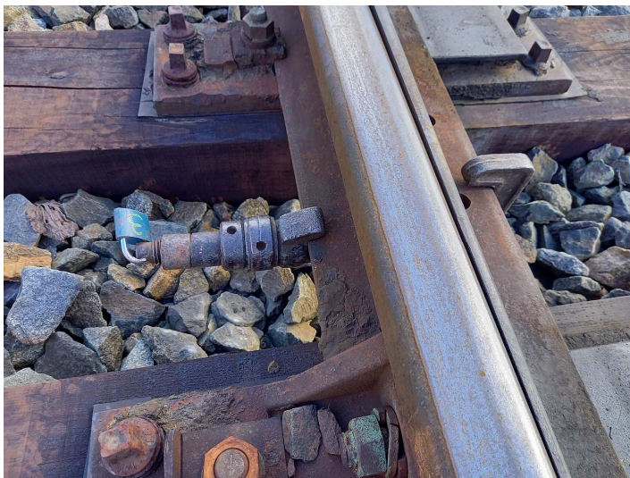
obrázek 142 – Příklad uzamknutí výhybky při osazení přenosného výměnového zámku ve druhém mezipražcovém poli
