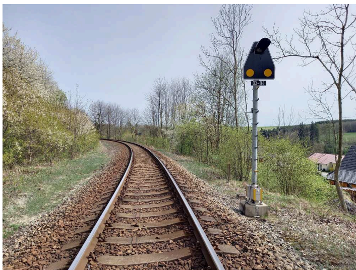
obrázek 419 – Přezedník s bílým světlem (příklad provedení jako opakovací přezedník)
