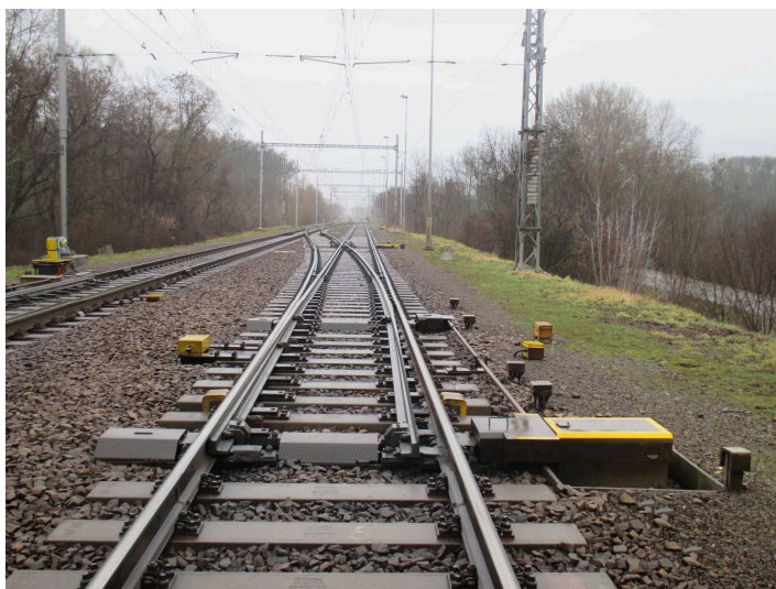
obrázek 53 – Jednoduchá výhybka s pohyblivým hrotem srdcovky (dále jen „PHS“)
