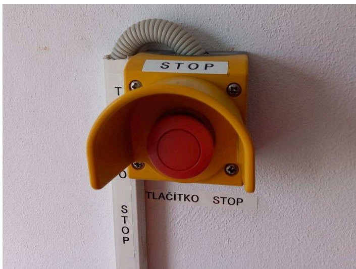
obrázek 437 – Tlačítko pro nouzové přestavení kmenového spádovištního návěstidla na návěst zakazující jízdu
