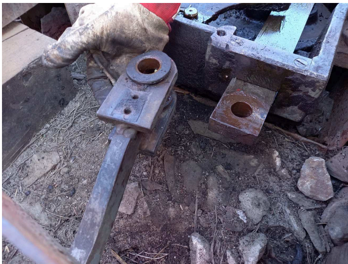
obrázek 170 – Vychýlení přestavné spojnice
