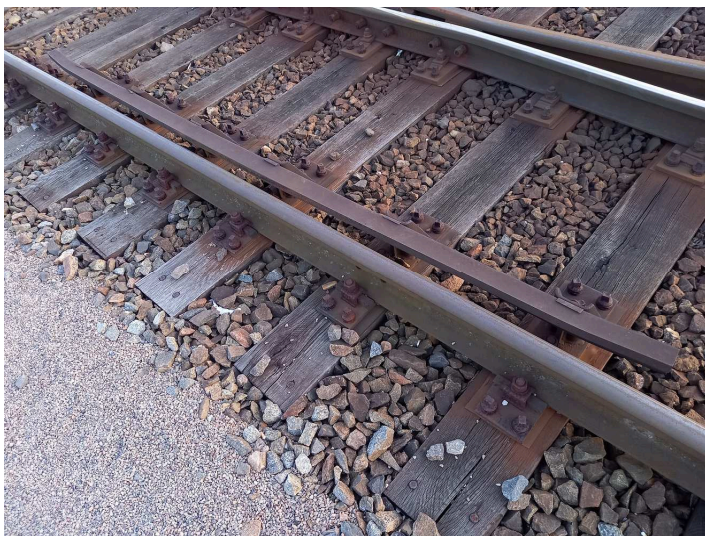
obrázek 70 – Přidržnice
