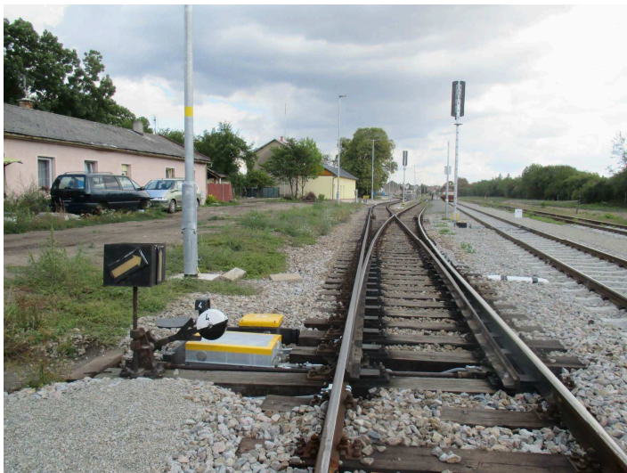
obrázek 194 – Závorník s elektrickým dohledem
