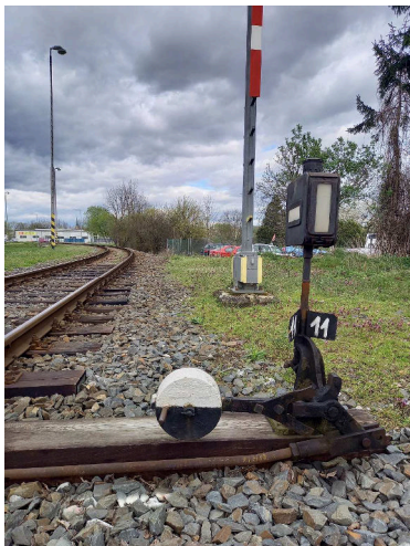
obrázek 79 – Výměník ručně přestavované výhybky
