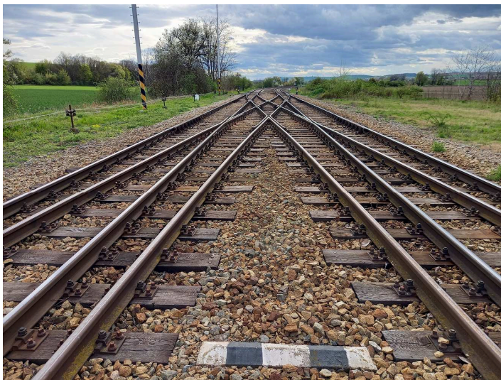
obrázek 65 – Dvojitá kolejová spojka
