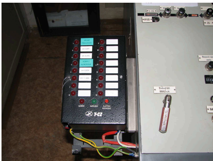
obrázek 444 – MPD 70 přijímač dat
