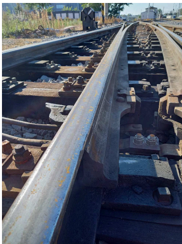
obrázek 67 – Jazyk (vnitřní) křížovatkové výhybky přiléhající k opornici
