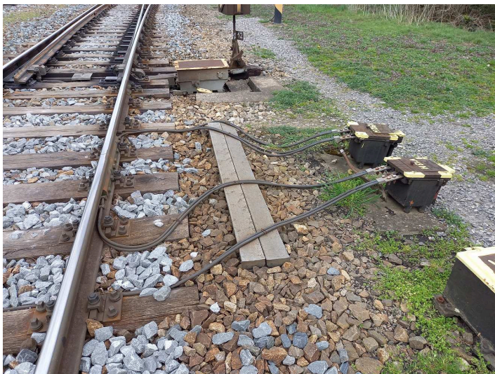
obrázek 227 – Výstroj izolovaného styku kolejového obvodu
