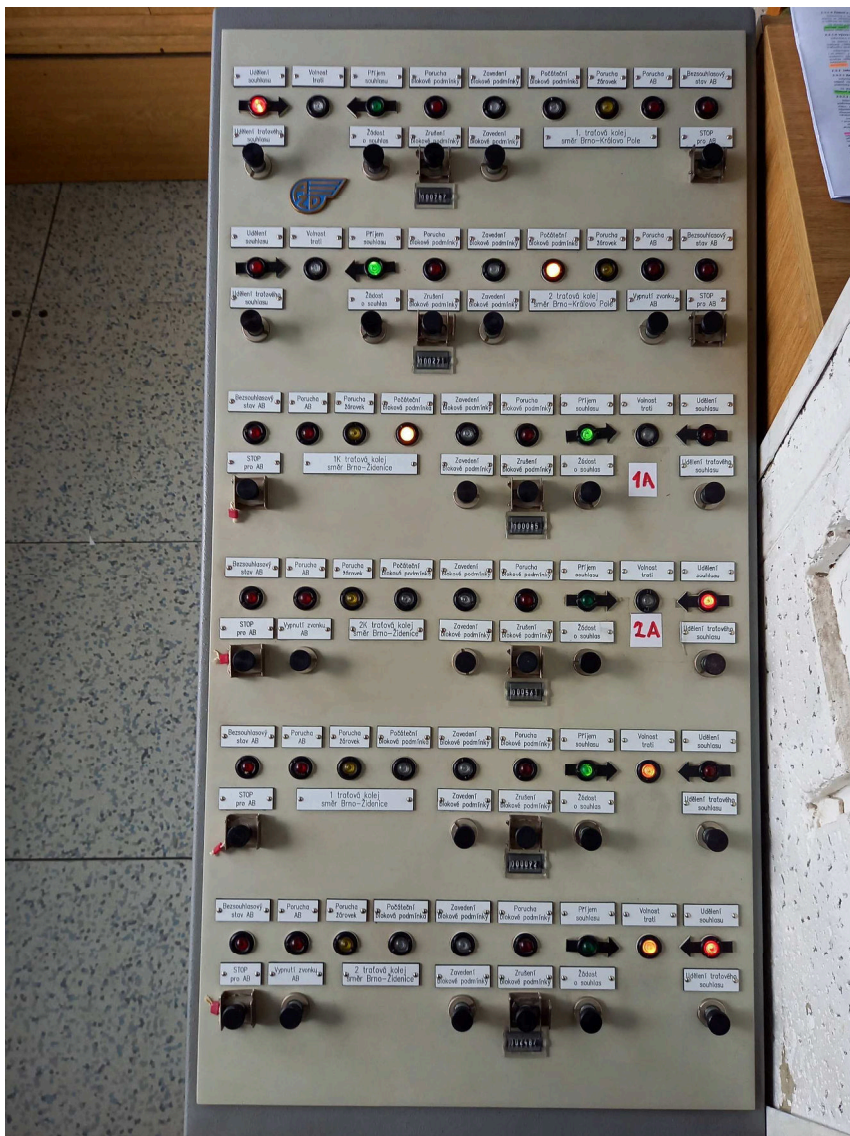
obrázek 391 – Příklad ovládacích a indikačních prvků automatického bloku ABE-1 na ovládacím stole
