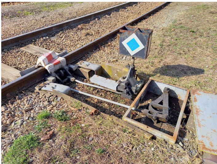
obrázek 184 – Mechanický záporník s jednou závorovací tyčí (na výkolejce)
