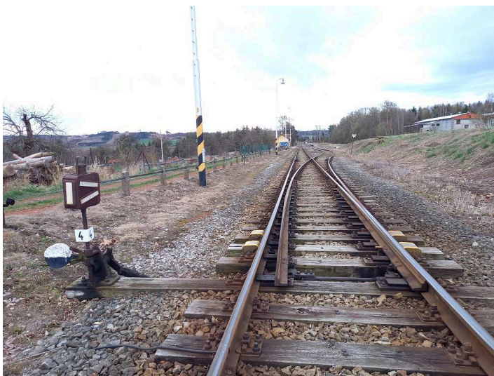
obrázek 49 – Jednoduchá výhybka pravá
