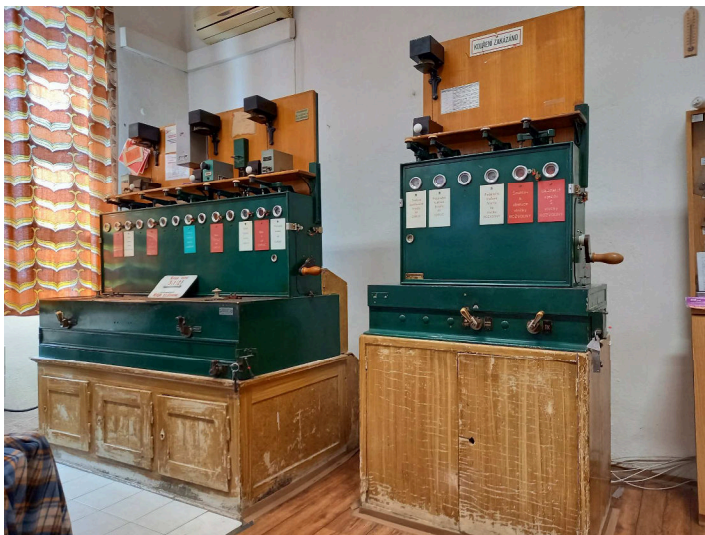
obrázek 243 – Přídavný přístroj (vpravo) s elektrickými závislostmi na řídicím přístroji
