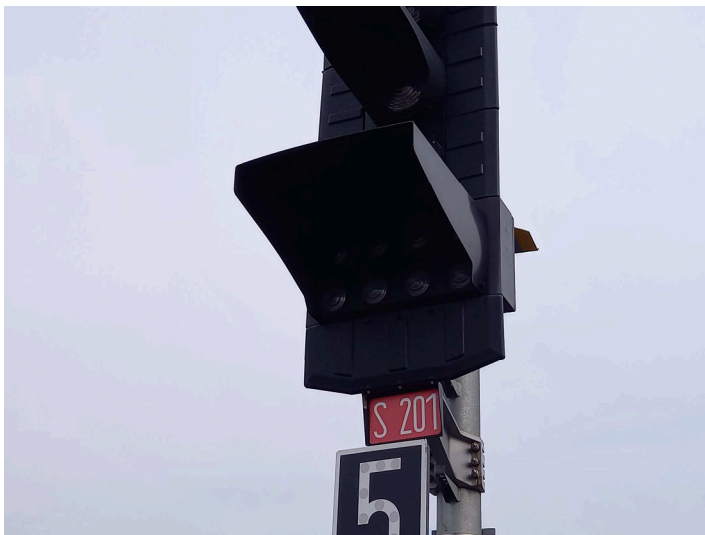
obrázek 209 – Detail světelného pruhu světelného hlavního návěstidla
