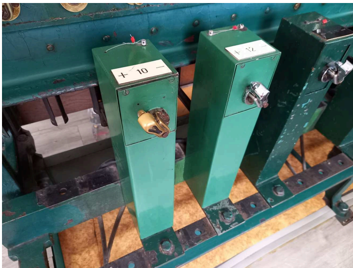
obrázek 275 – Výhybkový manipulátor, provedení, kde indikační prvky výhybky nebo výkolejky jsou umístěné samostatně na indikační desce
