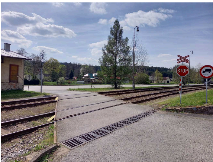
obrázek 396 – Přezjezd vícekolejný zabezpečený pouze výstražnými kříži
