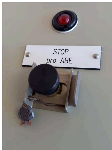
obrázek 6 – Tlačítko s uzávěrou proti náhodné obsluze novější typ, plombované (plomba na šňůrce)
