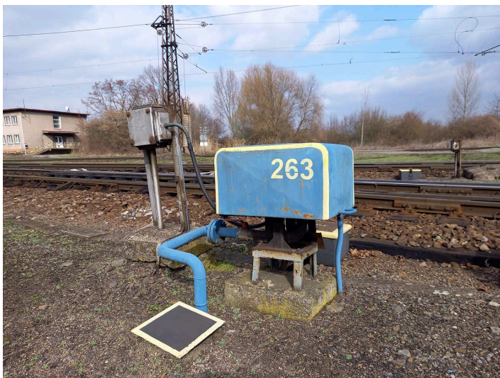
obrázek 423 – Regulační skříň kolejových brzd
