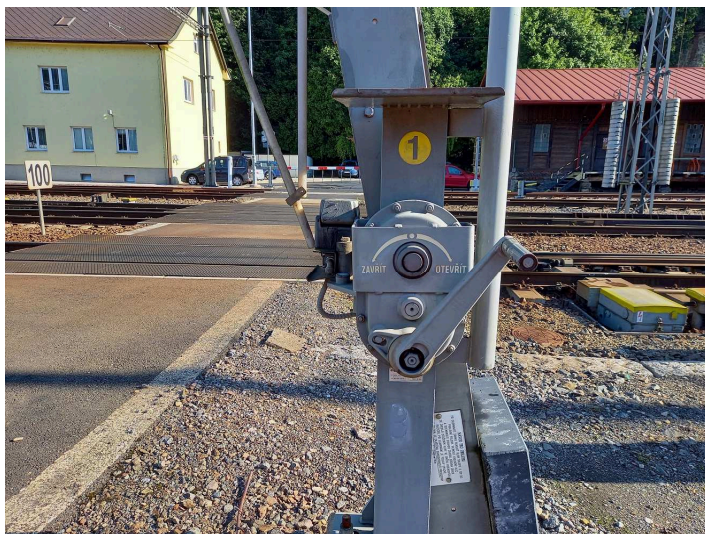
obrázek 405 – Detail PZM 2U (klika pohonu závory)
