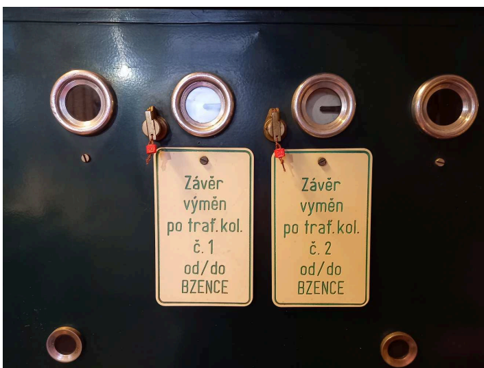
obrázek 335 – Hradlový závěr (závěr výměn) nahrazující samočinný závěr výměn
