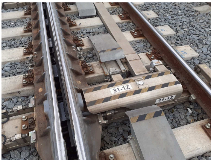
obrázek 179 – Hydraulický přestavník s vnitřním závěrem včetně krytu, v srdcovkové části výhybky s PHS
