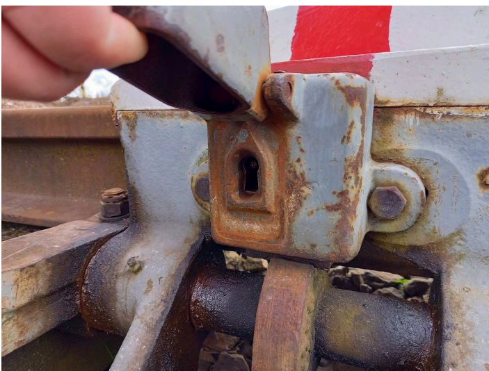
obrázek 113 – Výkolejkový zámek jednoduchý (novější typ výkolejky)
