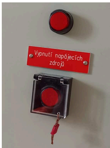
obrázek 22 – Tlačítko pod krytkou pro nouzové vypnutí napájení SZZ
