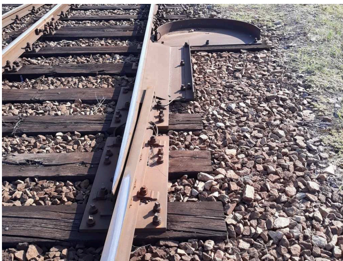
obrázek 442 – Zařízení pro automatické odstraňování zarážek pod svážným pahrbkem
