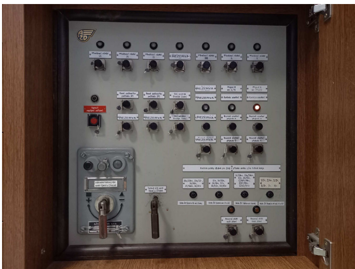
obrázek 367 – Deska nouzových obsluh pro menší stanice (součástí desky je i hlavní a náhradní traťový klíč)
