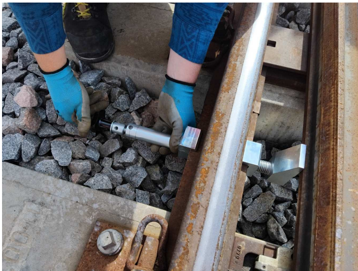
obrázek 142G – Zajištění zámku našroubováním otočné rúžice se závitem
