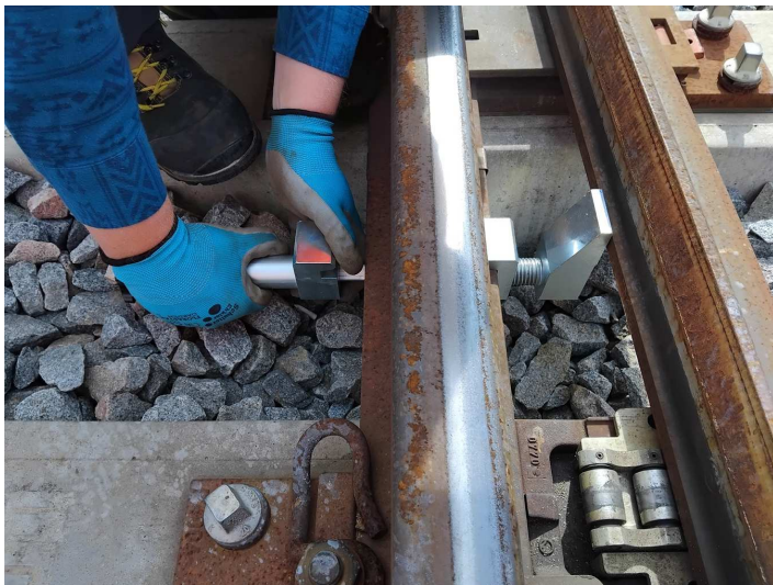
obrázek 142E – Dosažení odlehlého jazyka (závěrāk směruje kolmo vzhůru)
