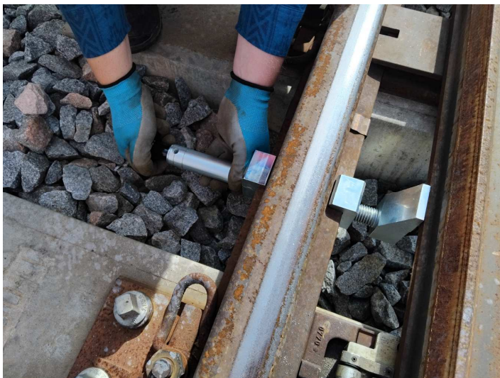
obrázek 142H – Dotážení otočné rúžice (otvory pro nasazení visacího zámku jsou v zákrytu)
