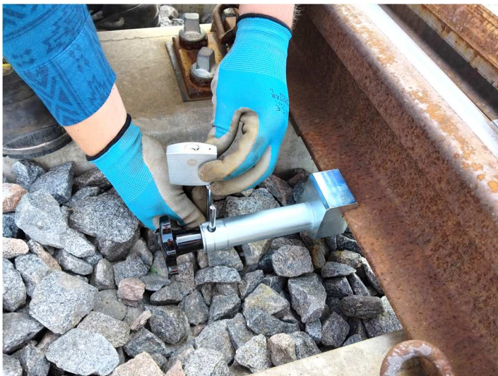
obrázek 142I – Uzamknutí přenosného odtlačného zámku visacím zámkem
