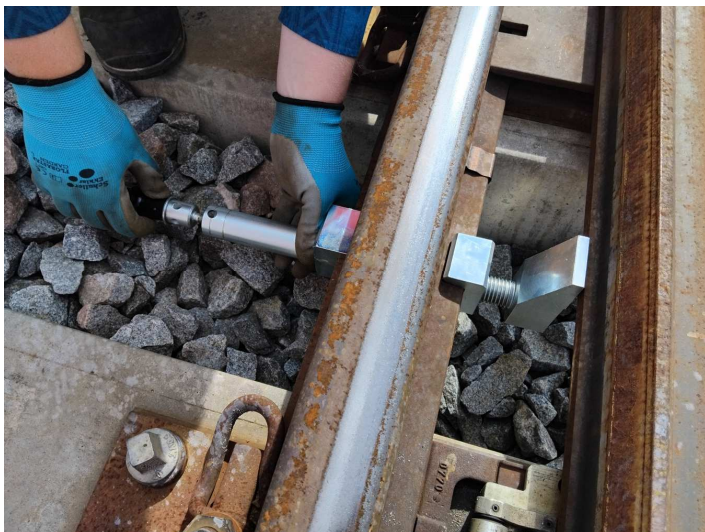
obrázek 142F – Nasazení zadní svěrky na opačný konec háku a její zaklesnutí za patu kolejnice
