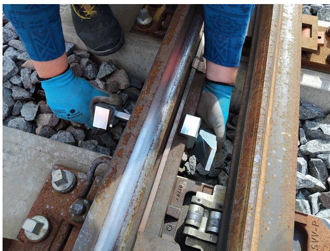
obrázek 142D – Otáčení závěrákem do dosažení odlehlého jazyka
