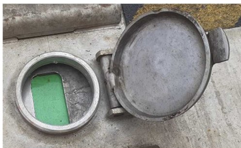
obrázek 11 – Uzavření vnitřního závěru v příslušné koncové poloze
