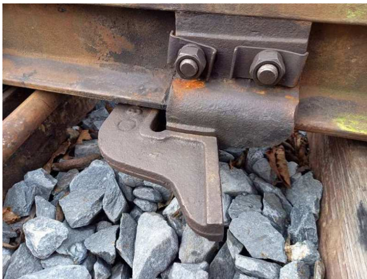
obrázek 3 – Úplné zaklesnutí závěrového háku u výhybky s hákovým závěrem jazyku
