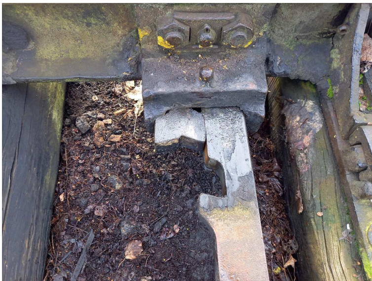
obrázek 7 – Nominální zajištění západky u výhybky s rybinovým závěrem jazyku
