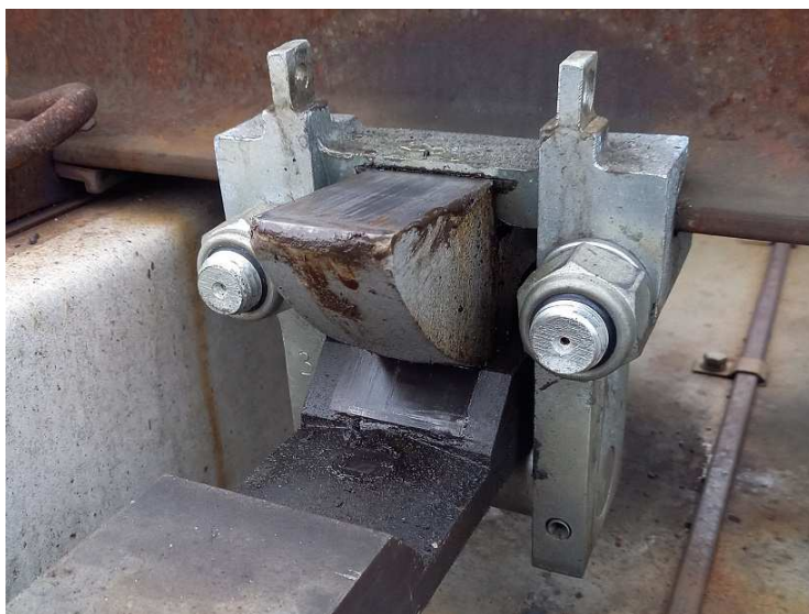
obrázek 5 – Nominální podepření závěrného háku u výhybky s čelistovým závěrem jazyku
