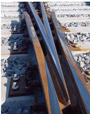
Křídlové kolejnice jednoduché výhybky
