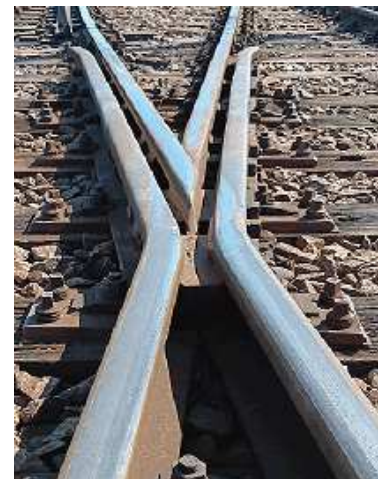
Křídlové kolejnice ve střední části DKS
