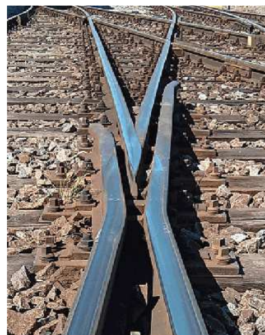
Křídlové kolejnice výhybky navazující na DKS
