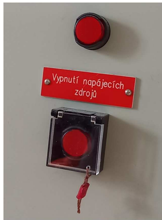
Příklad tlačítka pro nouzové vypnutí napájení SZZ
