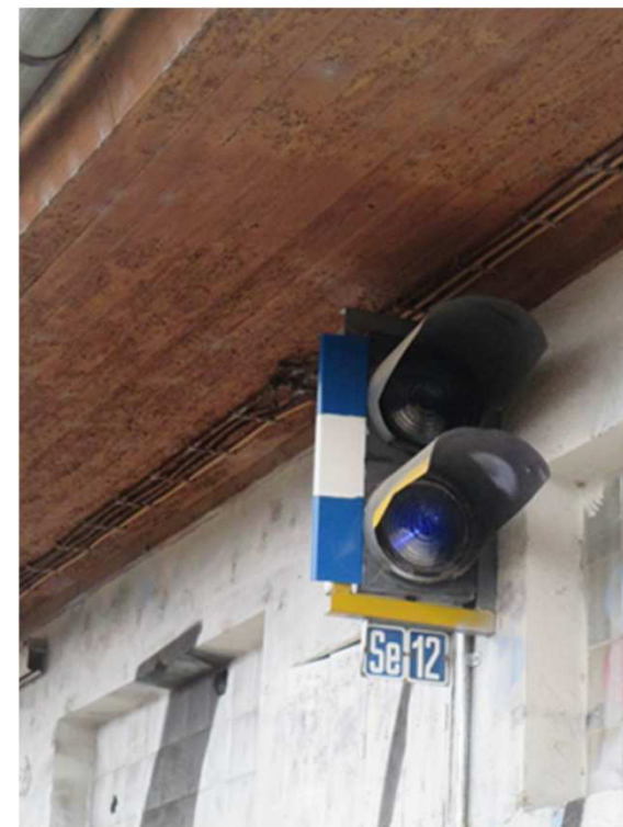
Stožárové návěstidlo umístěné na stěně budovy (označovací pás není v souladu s DAP)
