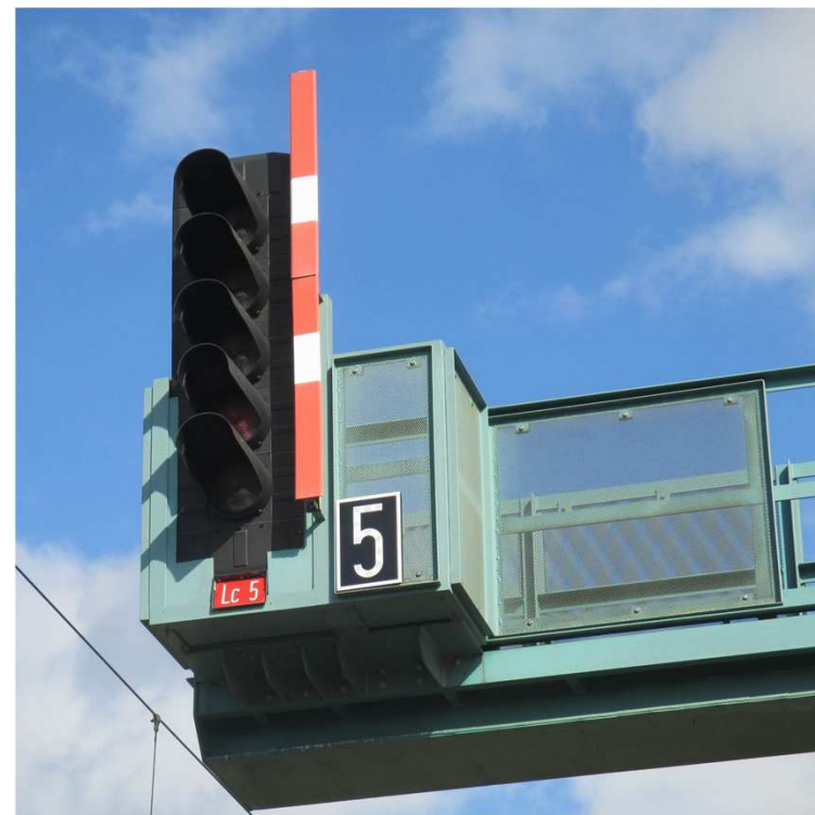
Krakorcové návěstidlo umístěné na krakorci (příklad provedení označovacího pásu není v souladu s normou TNŽ 34 2605)
