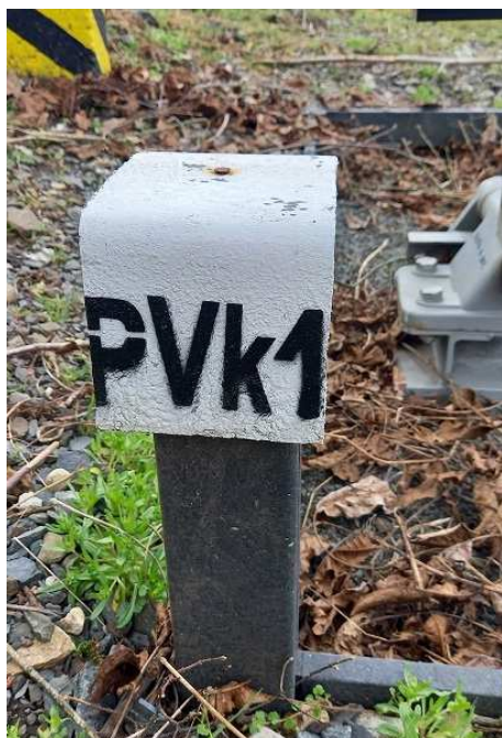
Označení výkolejky na sloupku
