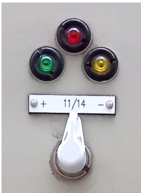
Příklad indikací fyzické spojky u SZZ neovládaného z JOP
