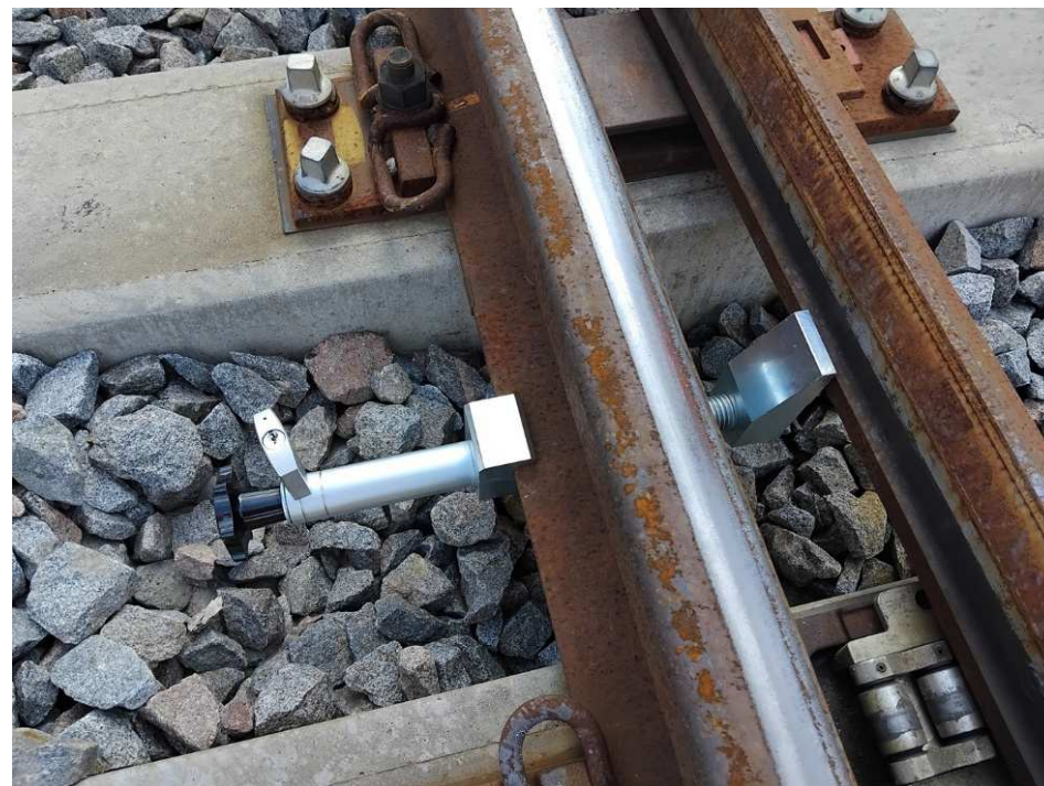
Příklad uzamknutí výhybky při osazení přenosného odtlačného zámku ve druhém mezipražcovém poli
