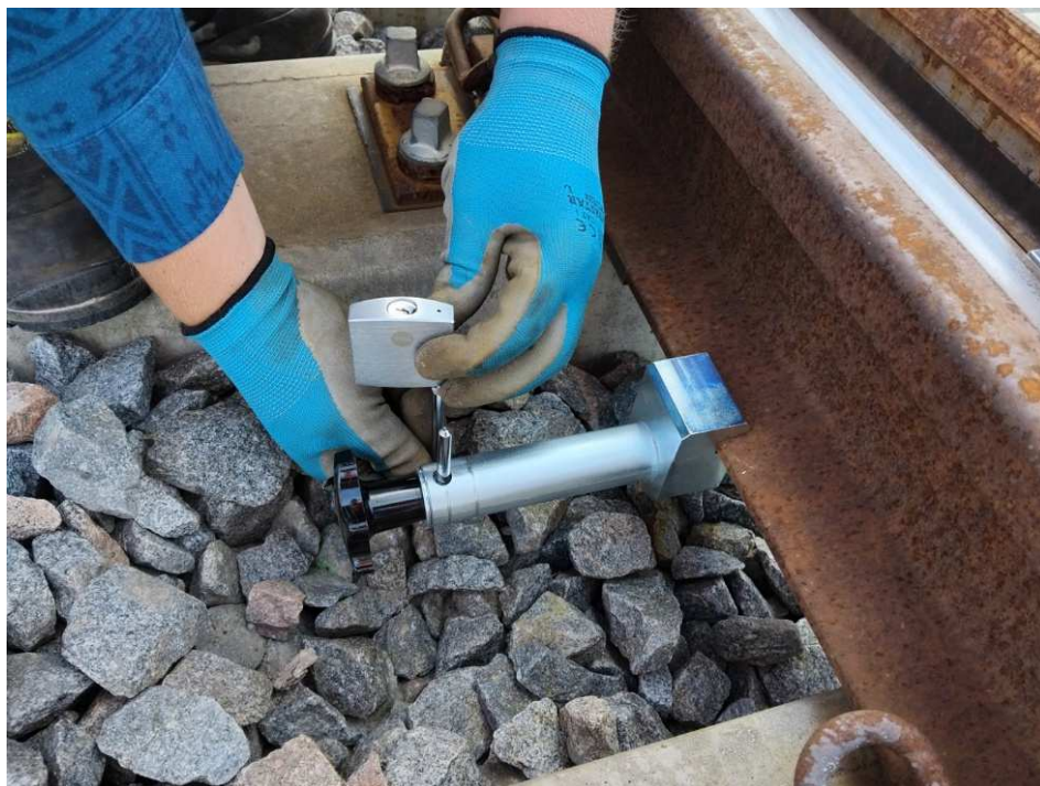
Uzamknutí přenosného odtlačného zámku visacím zámkem
