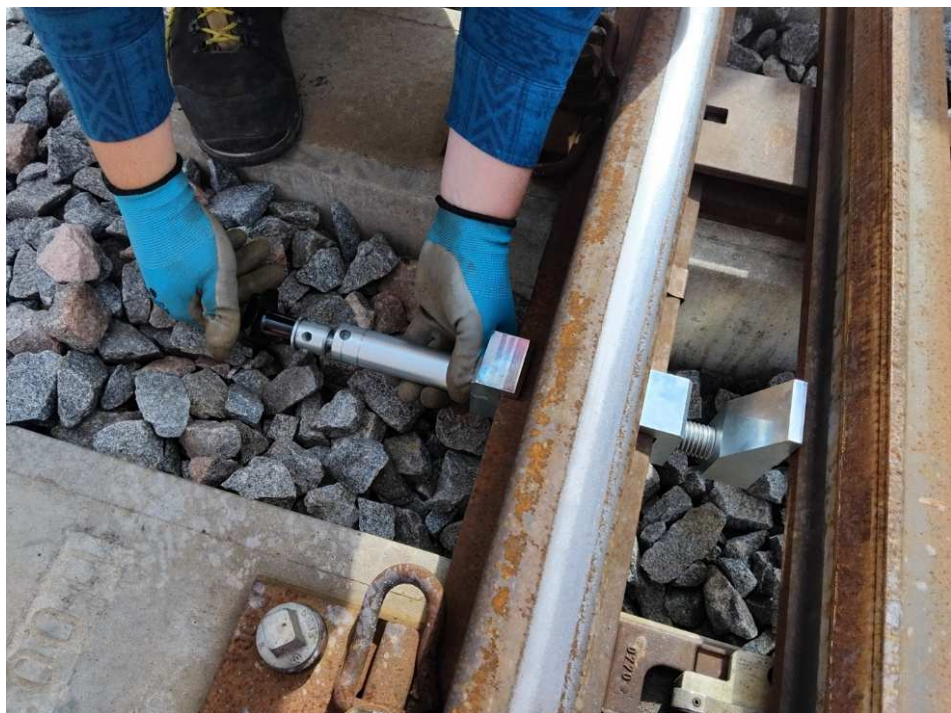
Zajištění zámku našroubováním otočné růžice se závitem
