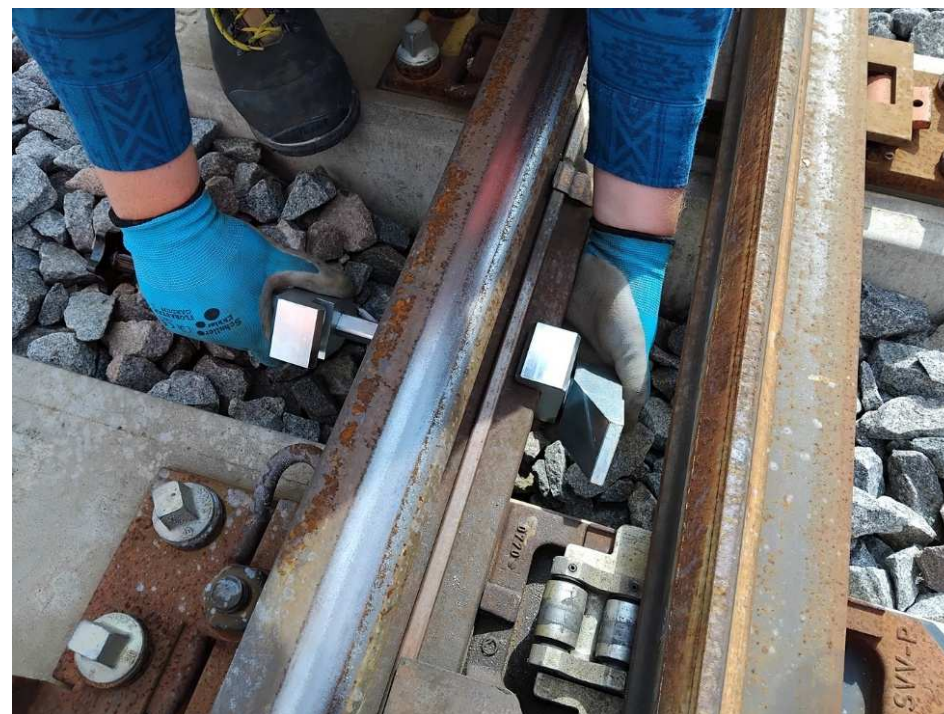
Otáčení závěrákem do dosažení odlehlého jazyka
