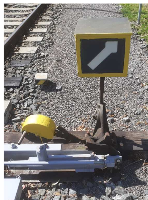
Závaží výměníku a výhybkové návěstidlo výhybky se samovratným přestavníkem
