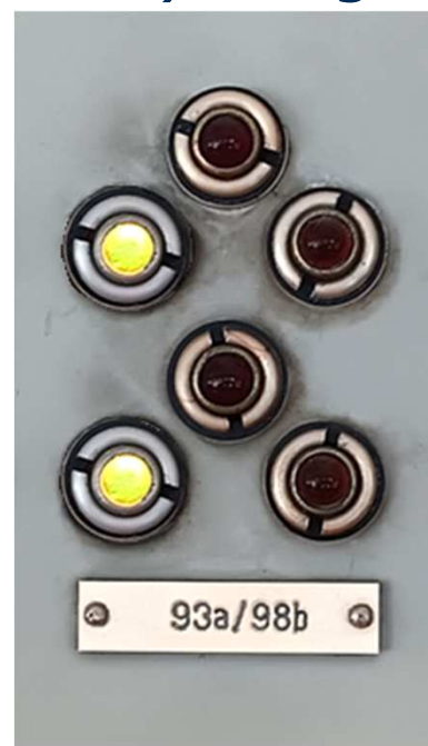
Příklad indikací logické spojky u SZZ neovládaného z JOP (indikace svisle)
