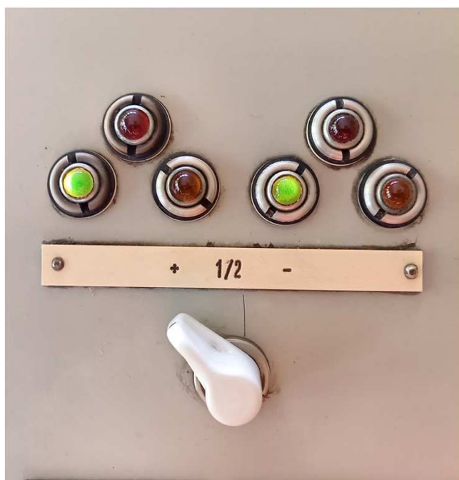
Příklad indikací logické spojky u SZZ neovládaného z JOP (indikace vodorovně)
