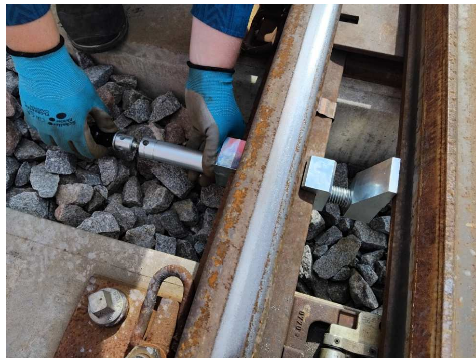
Nasazení zadní svěrky na opačný konec háku a její zaklesnutí za patu kolejnice
