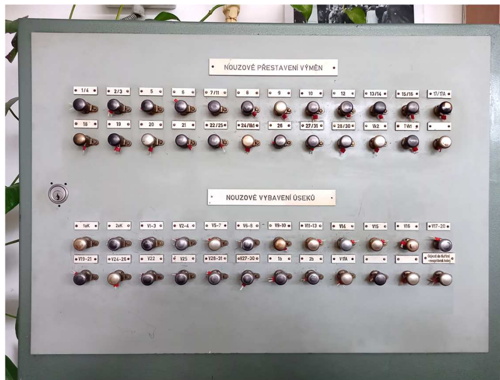
Příklad skříňky s nouzovými tlačítky
