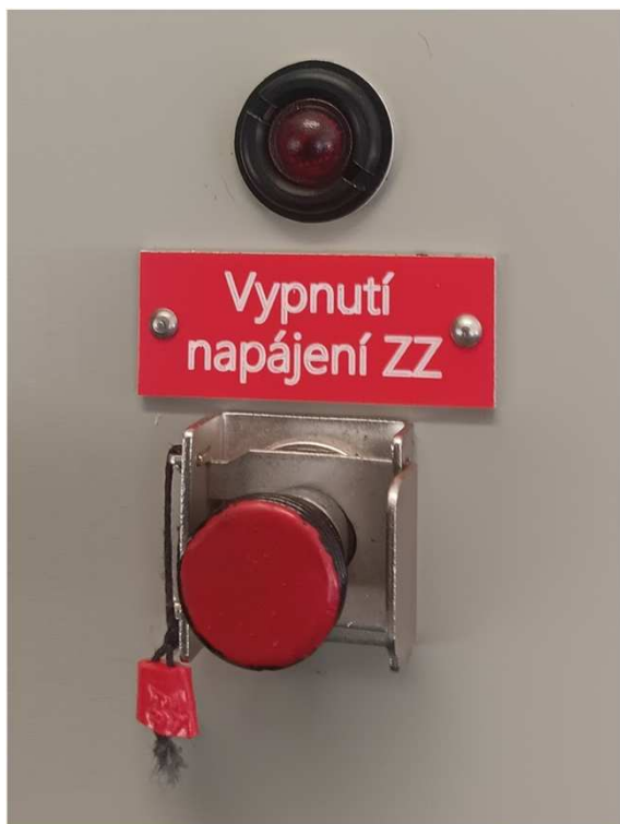
Příklad tlačítka pro nouzové vypnutí napájení SZZ
