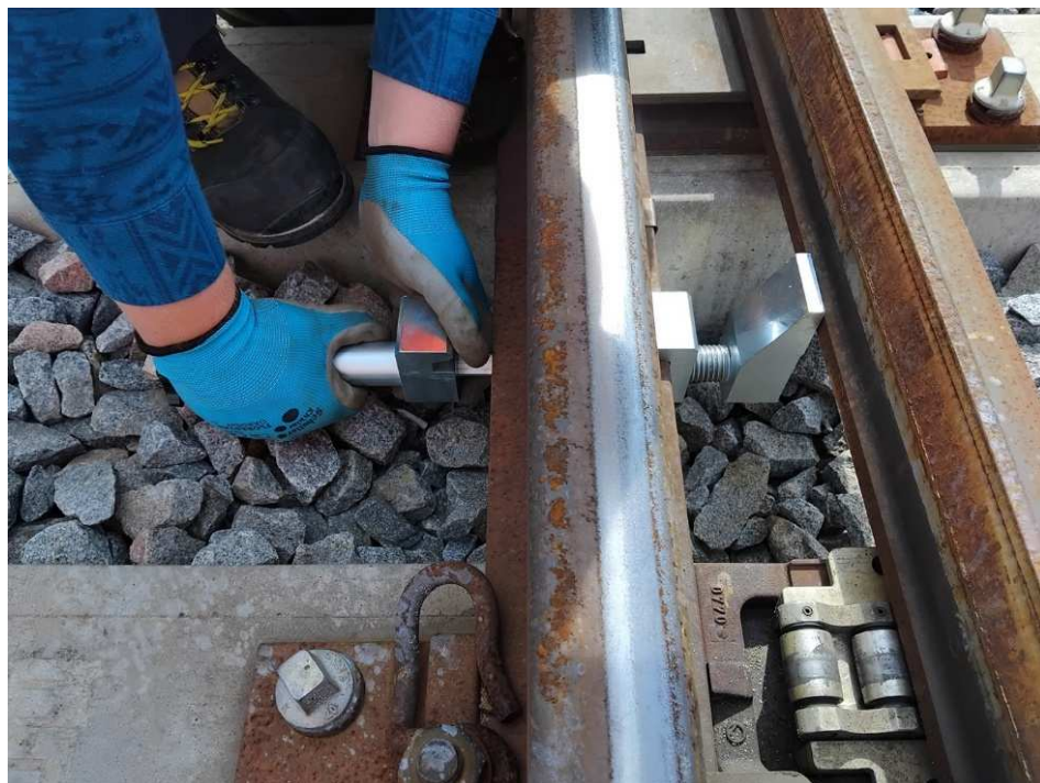
Dosažení odlehlého jazyka (závěrák směřuje kolmo vzhůru)
