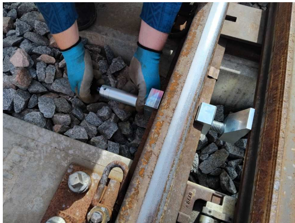
Dotažení otočné růžice (otvory pro nasazení visacího zámku jsou v zákrytu)
