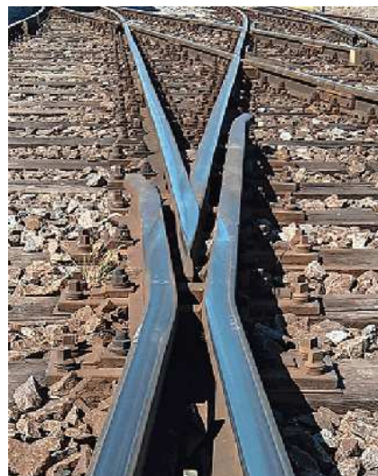
Křídlové kolejnice výhybky navazující na DKS
