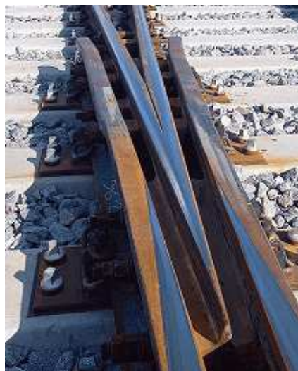
Křídlové kolejnice jednoduché výhybky
