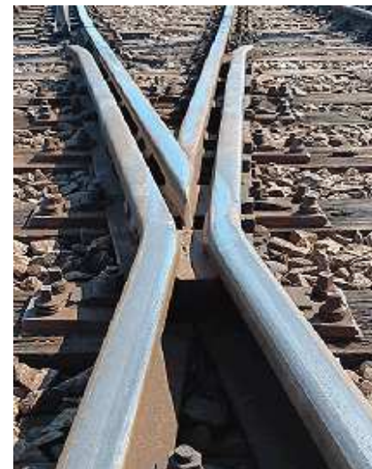
Křídlové kolejnice ve střední části DKS
