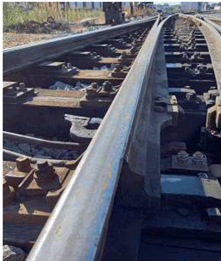
Jazyk křížovatkové výhybky přiléhající k opornici
