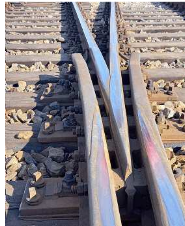
Hrot srdcovky složený ze dvou kusů (hlavní hrot vpravo)
