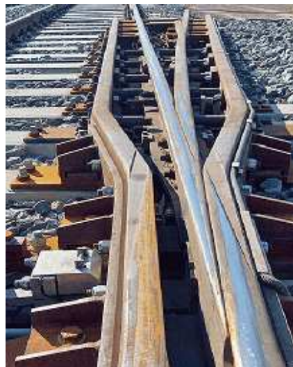
Křídlové kolejnice jednoduché výhybky s PHS
