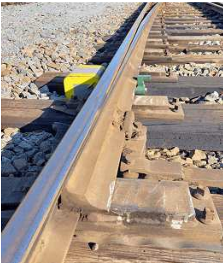
Jazyk jednoduché výhybky přiléhající k opornici
