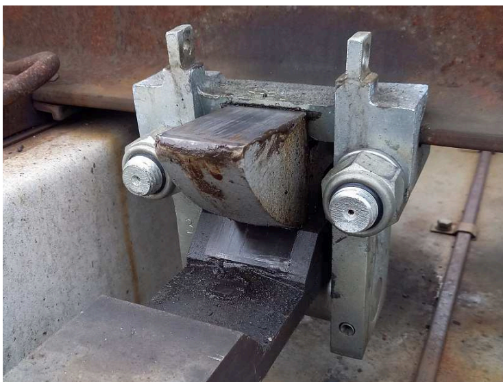
obrázek 5 – Nominální podepření závěrného háku u výhybky s čelistovým závěrem jazyku
