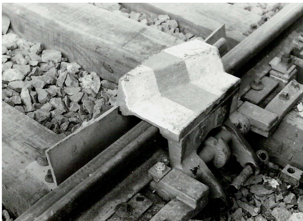
Výkolejka vypnutá z ústředního přestavování
