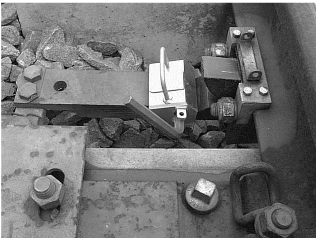
Přenosný zámek čelistového závěru
