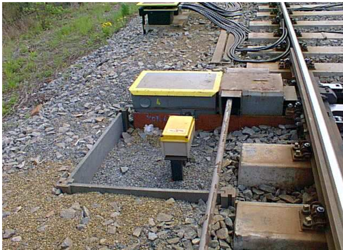
Žlabový prahec s vloženým elektrickým přestavníkem
